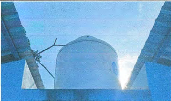
Foto 3. Modulo 2: sustitucion de deposito de agua
