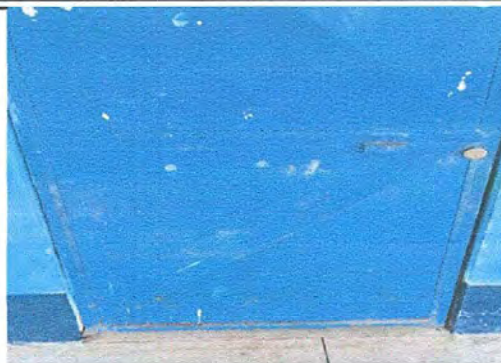
Foto 2. Modulo 1: mantenimiento de puertas
