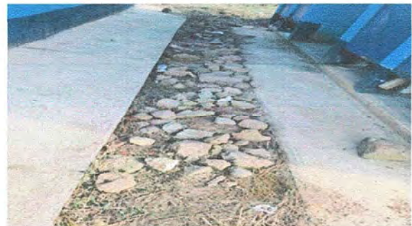
Foto 4. Modulo 2: Reparación de piso de torta de concreto
