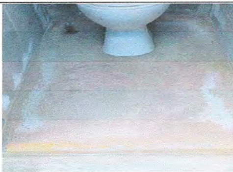
Foto 5. Modulo 2: Sustitucion de piso de torta de concreto por piso ceramico
