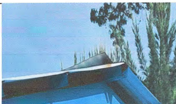
Foto 5. Modulo 1: Sustitucion de capotes de lamina para lamina troquelada
