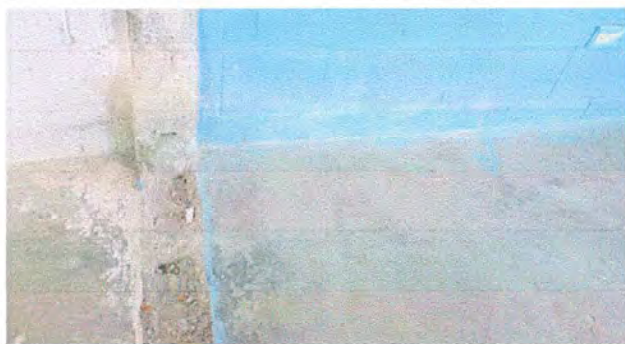
Foto 1. Modulo 1: Sustitucion de piso de torta de concreto por piso ceramico
