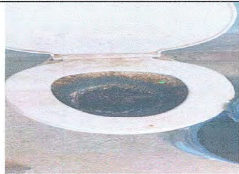
Foto 2. Modulo 2: Sustitucion de inodoro
