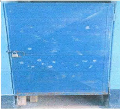
Foto 1. Modulo 2: Sustitucion de puerta en servicios sanitarios
