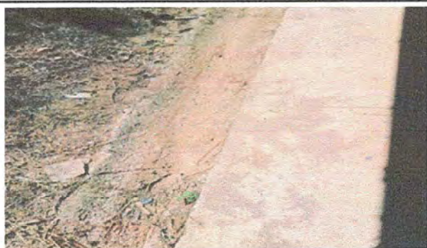
Foto 3. Modulo 1: Reparacion de cuneta de concreto
