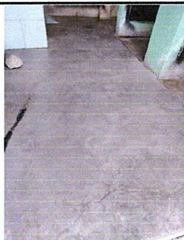
Foto 5: piso de los sanitarios No. 1
