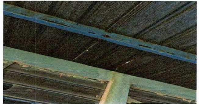
Foto 2: MODULO 1: Sustitución de lámina, por lámina troquelada aluzinc calibre 26.
