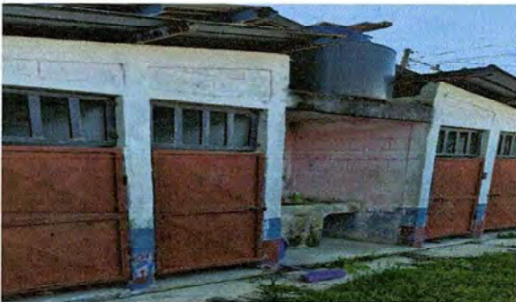
Foto 3: MODULO 2, BAÑO: Sustitución de lámina por lámina troquelada aluzinc calibre 26.
