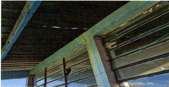
Foto 1: MODULO 1: Sustitución de vidrios.
