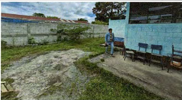
Foto 5: PATIO: Reparación de entortado de patio.
