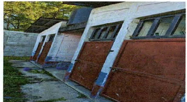
Foto 4: MODULO 2, BAÑO: Reparación de puertas en servicios sanitarios.
