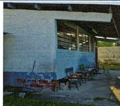
Foto 6: MODULO 1, AULA: Aplicación de pintura a paredes de el aula.
