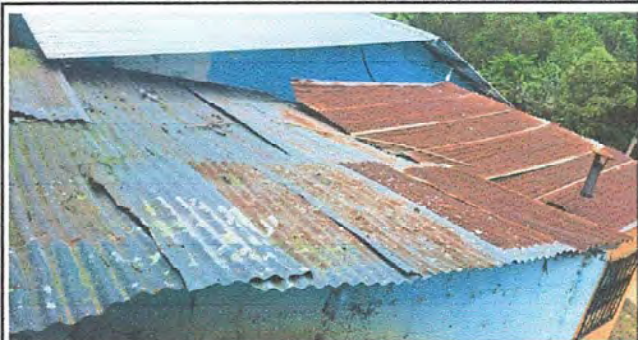
FOTO 1. MODULO 1: Sustitucion de lamina por lamina troquelada.
