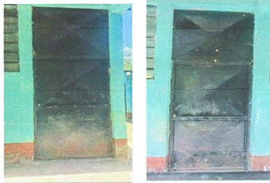
FOTO 4. MODULO 1: Sustitucion de chapa.
