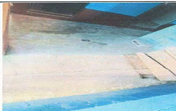
FOTO 9. MODULO 1: Sustitucion de piso de torta de concreto
