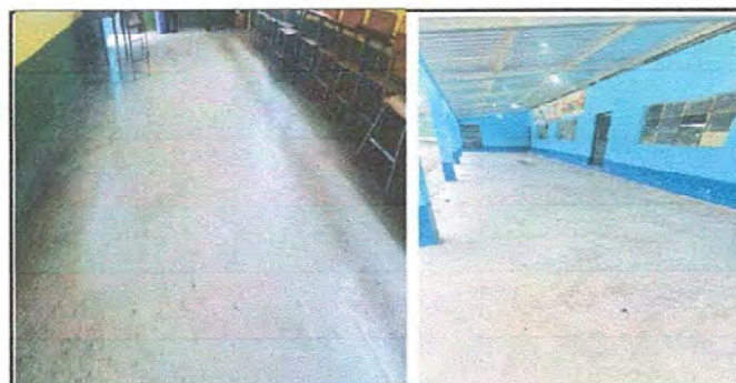
FOTO 6. MODULO 1: Sustitucion de piso ceramico.
