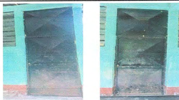
FOTO 5. MODULO 1: Mantenimiento a estructura de puerta.
