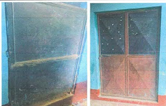
FOTO 3. MODULO 1: Sustitucion de de puerta.
