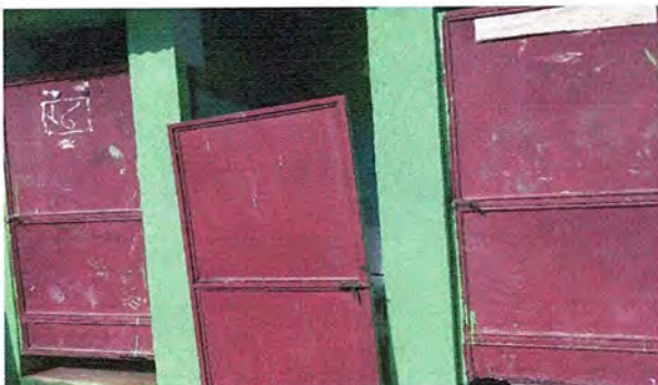
FOTO 5. MODULO 1: sustrucion de puertas en servicios sanitarios
