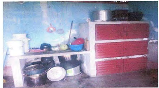
FOTO 14. MODULO 2: Reparacion de azulejo en muebles de cocina
