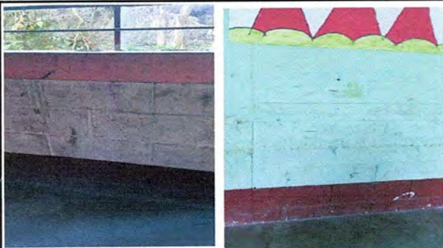
FOTO 15. MODULO 2: Pintura General
