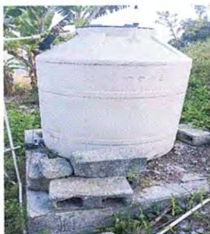
FOTO 9. MODULO 1. Sustrucion de deposito de agua.
