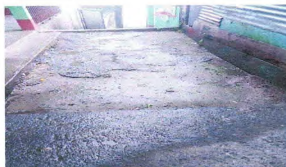
FOTO 12. MODULO 2: Reparacion de planchas de concreto de patio
