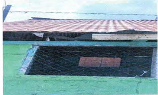
FOTO 6. MODULO 1: Sustrucion de ventanas de madera por metal.
