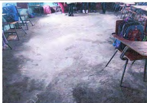
FOTO 8. MODULO 1: Sustrucion de piso de cemento liquido.
