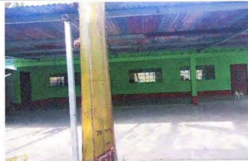
FOTO 16. MODULO 2: Pintura general
