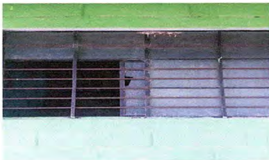
FOTO 7. MODULO 1: Sustrucion de vidrios
