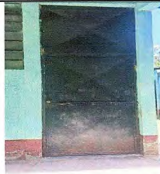
FOTO 4. MODULO 1: Sustrucion de puertas
