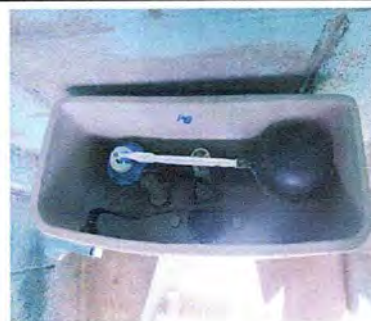
FOTO 10. MODULO 1: Sustrucion de accesorios inodoro
