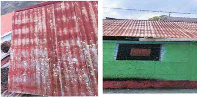
FOTO 1. MODULO 1: Sustrucion de lamina por lamina troquelada.
