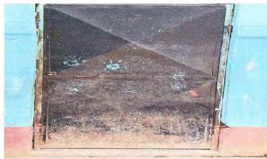
Foto 8: Módulo 4. Mantenimiento a estructura de puerta (lijado, cepillado, y aplicado de pintura)
