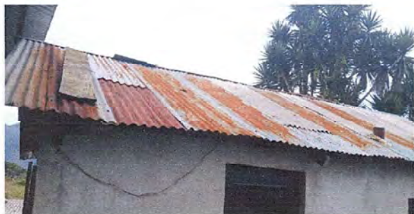
Foto1: Módulo 1 . Sustitución de lámina por lámina troquelada y pintura en muros exteriores e interiores.
