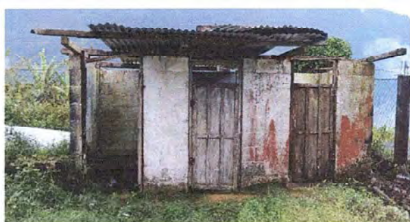
Foto 3: Módulo 2. Sustitución de lámina, por lámina troquelada, Sustitución de estructura de soporte de madera, por metal y Sustitución de puerta en servicios sanitarios
