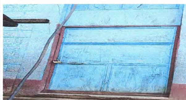
Foto 4: Módulo 3. Sustitución de puerta de metal
