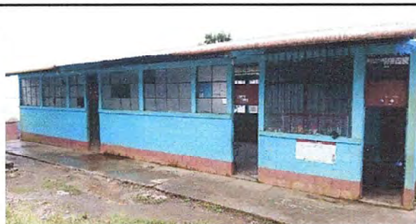
Foto 5: Módulo 3. Suministro e instalación de ventana-balcon de metal de enfrente y pintura en muros exteriores.
