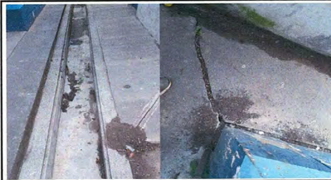
Foto 4: Reparación de cuneta de concreto en módulo 1
