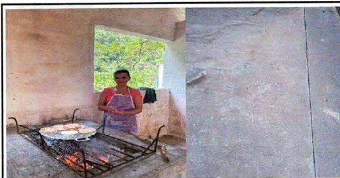
Foto 5: Colocación de ventana, puerta y piso cerámico en cocina y sustitución de estufa rural completa.
