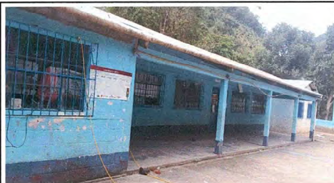
Foto1: Mantenimiento a estructura de soporte de metal y sustitución de lámina por lámina troquelada aluzinc calibre 26 módulo 1
