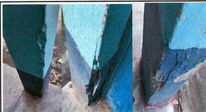
Foto 3: Sellado de grietas y fisuras en muros en módulo 1
