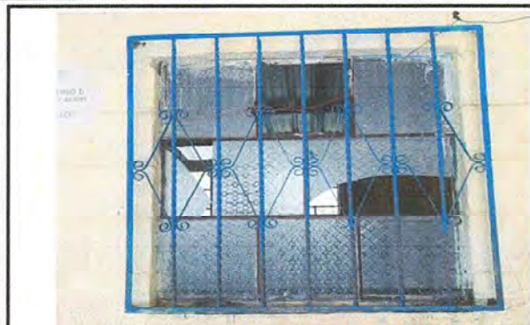
Foto 7: Sustrucción de vidrios quebrados en módulo 1
