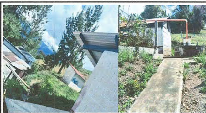
Foto 8: Instalación de tubo PVC para bajada de agua pluvial para el tanque de captación en módulo 1
