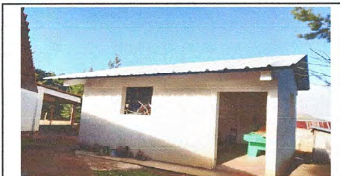
Foto 5: Colocación de ventanas, puerta, bajada pluvial de agua, llave de chorro e instalación eléctrica en módulo 3
