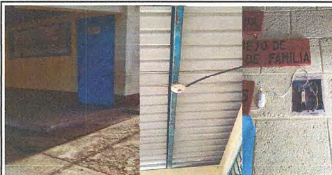
Foto 4: Aplicación de pintura e instalación de cableado eléctrico y accesorios en módulo 2
