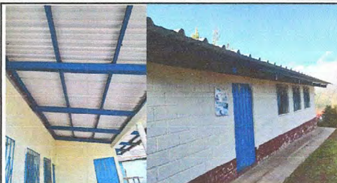
Foto 2: Instalación cableado eléctrico: tomacorrientes, plafoneras, interruptor, bombillas, sustitución de canal de PVC y reparación de bajada de agua pluvial en módulo 1
