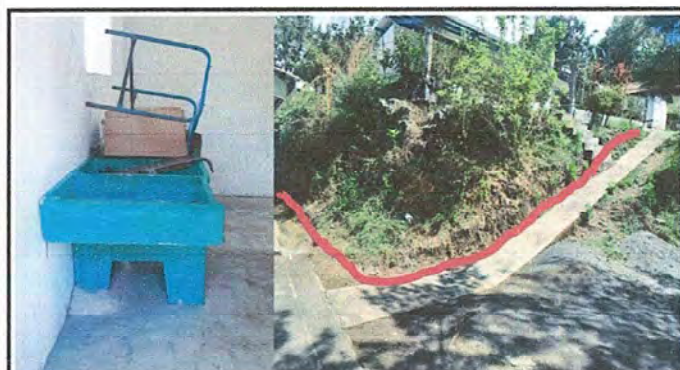
Foto 9: Instalación de tubería para agua potable en módulo 3.
