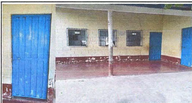
Foto 1: Lijado de puertas, cambio de marco y chapas, cambio de vidrios y aplicación de pintura en módulo 1
