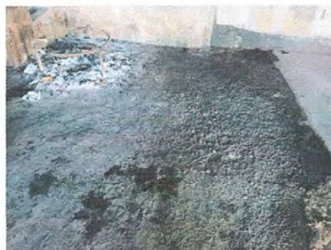
MÓDULO 2. Foto 10: Reparación de piso de torta de concreto.
