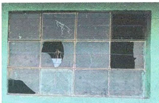
MÓDULO 2. Foto 9: Sustitución de balcon de metal.
