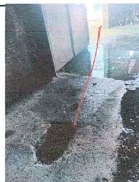
MÓDULO 2. Foto 18: Sustitución de tubería PVC.
