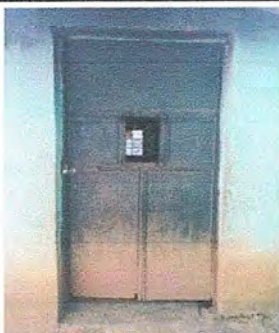
MÓDULO 2. Foto 5: Sustitución de puerta.
