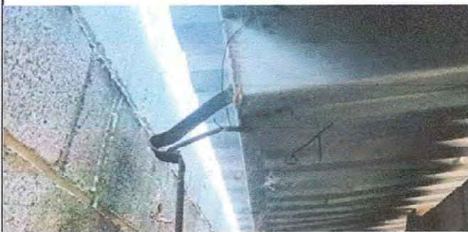
MÓDULO 1. Foto 3: Sustitución de soporte o pescante de metal para canal
