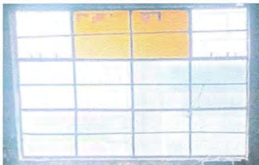
MÓDULO 2. Foto 7: Sustitución de estructura de metal de ventanas.
