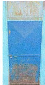
MÓDULO 3. Foto 6: Sustitución de puertas.
