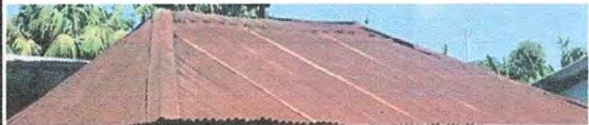
MÓDULO 2. Foto 16: Sustitución de capote de lámina por lámina troquelada.
