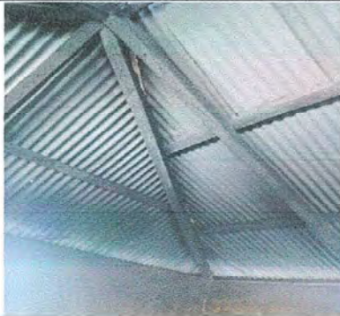
MÓDULO 2. Foto 13: Sustitución de estructura de soporte de madera por metal (tubos cuadrados)
