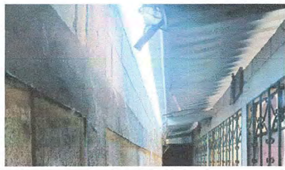
MÓDULO 1. Foto 2: Sustitución de canal de metal
