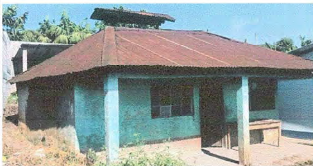
MÓDULO 2. Foto 15 : Sustitución de lámina, por lámina troquelada aluzinc calibre 26.
