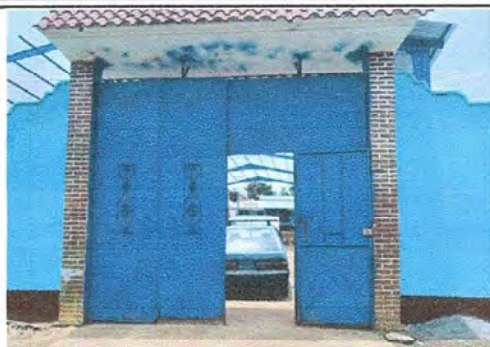
MODULO 4. Foto 19: Sustitución de portón
