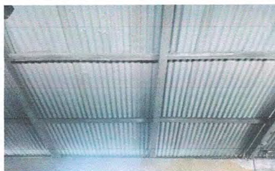
MÓDULO 2. Foto 12: Sustitución de estructura de soporte de madera por metal (costaneras)
