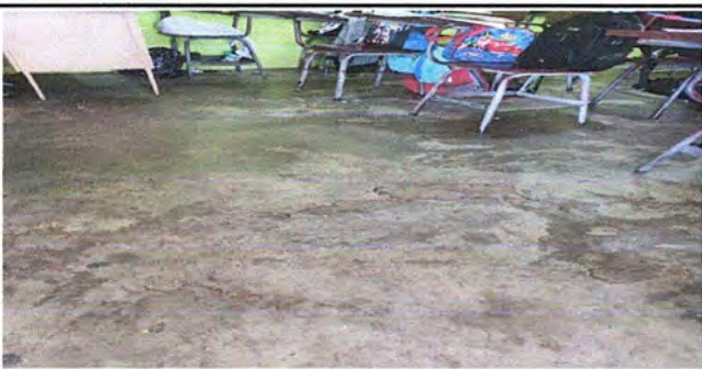
Foto 3: MODULO 2 Sustitución de piso de torta de concreto, por piso cerámico en aulas
