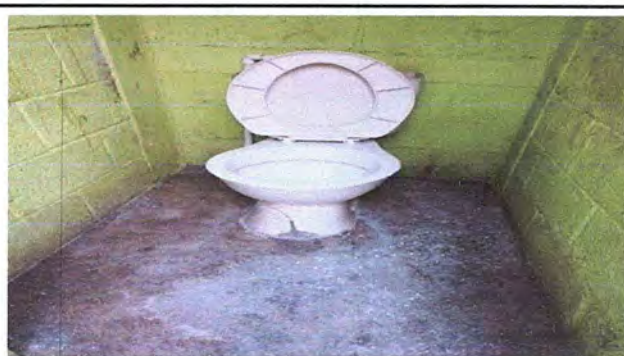
Foto 4: MODULO 2 Sustitución de piso de torta de concreto, por piso antideslizante en baños.
