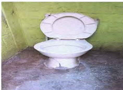
Foto 7: MODULO 2 Sustitución de inodoro
