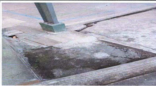
Foto 2: MODULO 2 Reparación de piso de torta de concreto
