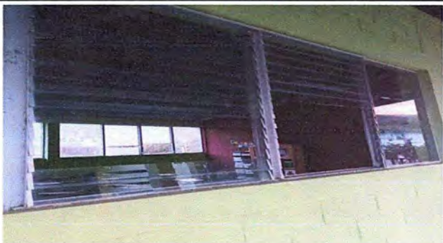
Foto 1: MODULO 1. Sustitución de ventanas de aluminio, por PVC
