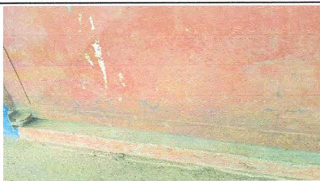
Foto 3: Mantenimiento de puerta (Aplicación de pintura)
