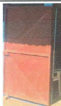
Foto 4: Mantenimiento de puerta (Aplicación de pintura)
