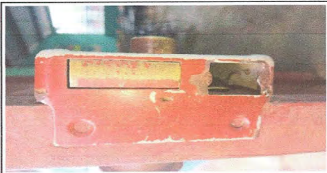
Foto 6: Sustitución de chapas
