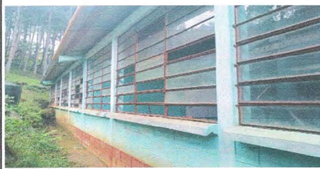
Foto 2: Sustitución de vidrios y Suministro e instalación de balcon de hierro en ventana.
