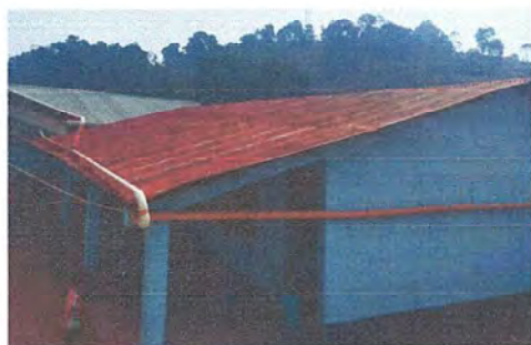
FOTO 1: Sustitución de láminas, por láminas troqueladas alucinc calibre 26
