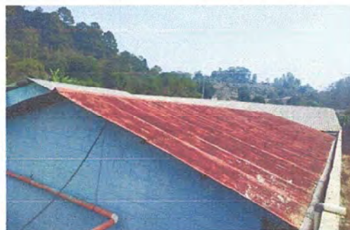
Foto 2: Pintura en muros interiores exteriores
