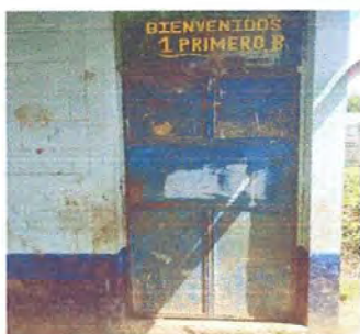
Foto 3: Sustitución de puerta
