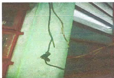
Foto 12: reparación de cableado eléctrico
