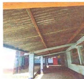
Foto 4: Mantenimiento de estructura de soporte de metal
