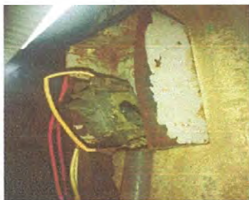
Foto 11: sustitución de interruptores
