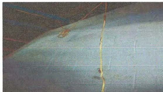
Foto 8: sustitución de cableado eléctrico
