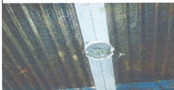
Foto 6: sustitución de plafoneras
