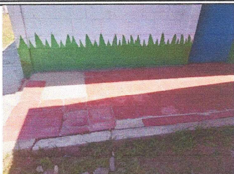
Foto1: MÓDULO 1:Sustrucción de piso de cemento líquido
