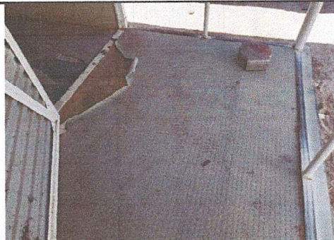
Foto 4: MÓDULO 4: Reparación de piso de tabla roca
