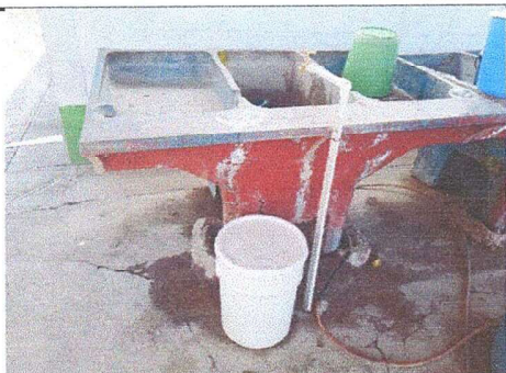
Foto 3: MÓDULO 2: Sustrucción de pila de cemento de dos lavaderos
