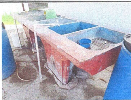
Foto 2: MÓDULO 2: Sustrucción de pila de cemento de dos lavaderos
