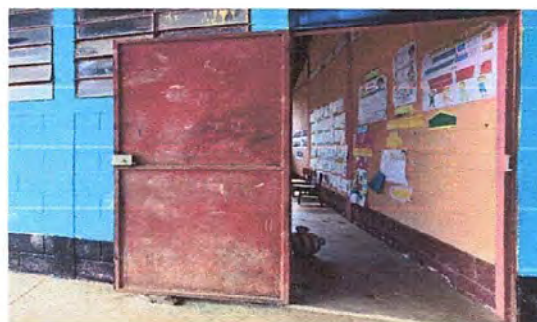
Modulo 2: Foto 4: Mantenimiento a estructura de puerta (lijado, cambio de tubo, cepillado, sujeciones, aplicación de pintura)
