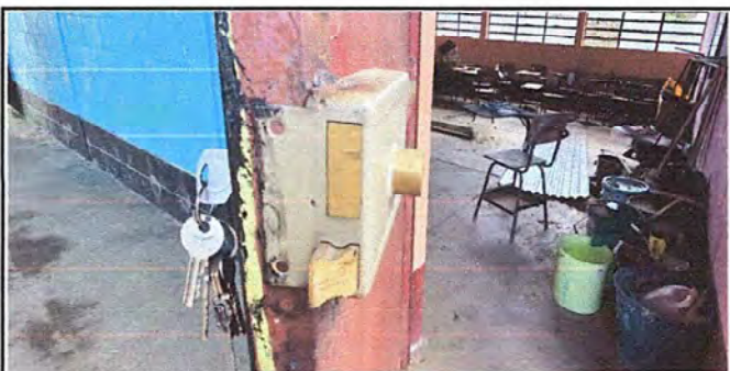
Modulo 2: Foto 5: Sustitución de chapas
