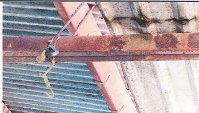
Modulo 1: Foto 2: Mantenimiento a estructura de soporte de metal
