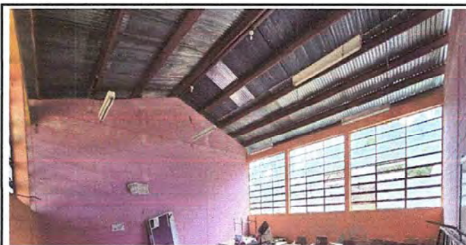
Modulo 2: Foto 3: Sustitución de lámina, por lámina torquelada aluzinc calibre 26
