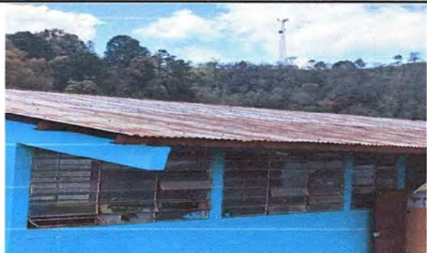
Modulo 1: Foto 1: Sustitución de lámina, por lámina torquelada aluzinc calibre 26
