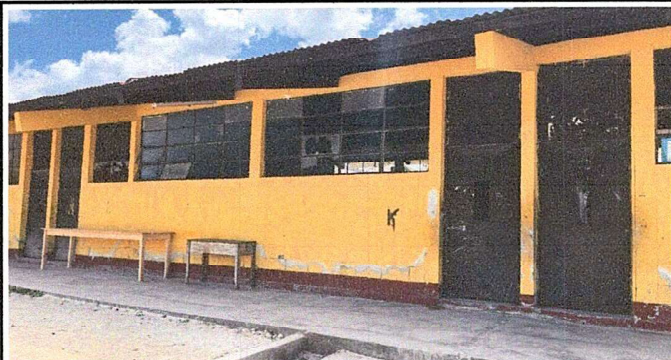
Foto 2: Módulo 1. Mantenimiento de estructura de puerta de metal (lijado, cepillado y aplicación de pintura).
