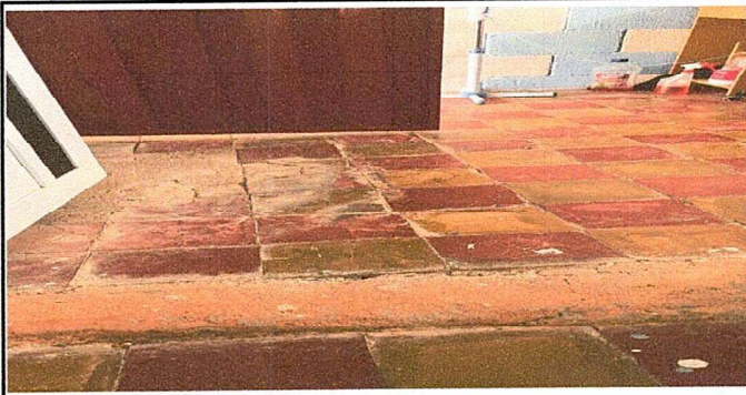
Foto 4: Módulo 3. Sustitución de piso de cemento líquido por piso de cerámica.
