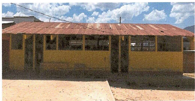
Foto1: Módulo 1. Sustitución de estructura de metal de ventana por PVC y fabricación e instalación de balcon de hierro en ventanal.
