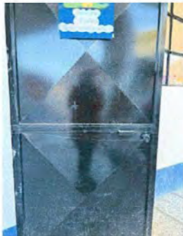
Foto 3: MODULO I SUSTITUCIÓN DE CHAPAS
