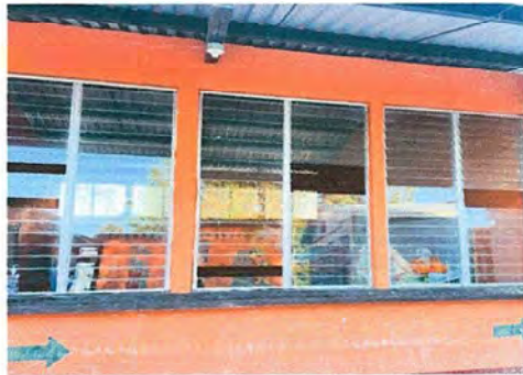
Foto 1: MODULO I SUMINISTRO E INSTALACIÓN DE BALCONES
