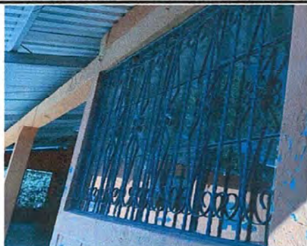
Foto 7: MODULO II MANTENIMIENTO A BALCONES
