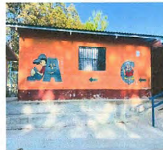
Foto 4: MODULO I SUSTITUCIÓN DE CANAL PVC
