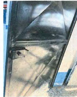
Foto 2: MODULO I MANTENIMIENTO A ESTRUCTURAS DE PUERTAS
