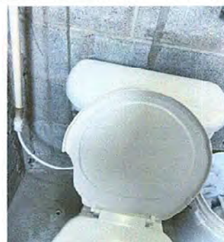
Foto 8: MODULO III SUSTITUCIÓN DE INODOROS
