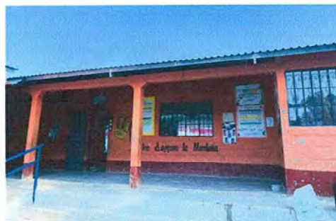
Foto 5: MODULO II SUSTITUCIÓN DE CANAL DE PVC
