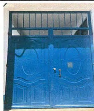
Foto 10: MANTENIMIENTO A PORTON GENERAL
