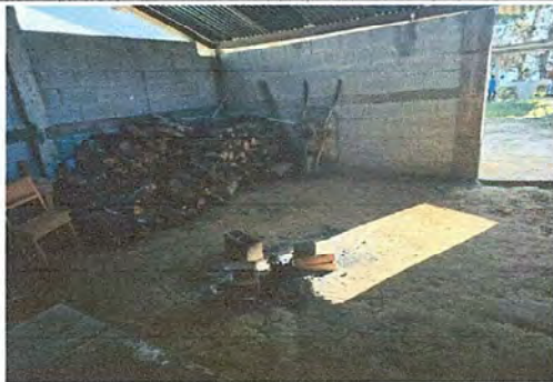
Foto 3: MODULO II Sustitución de torta de concreto por piso ceramico
