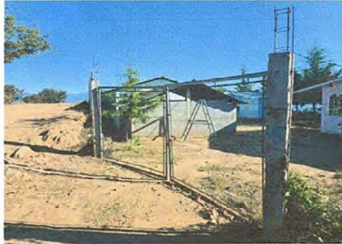
Foto1: Modulo I Fabricación e instalación de portón de Metal de ingreso
