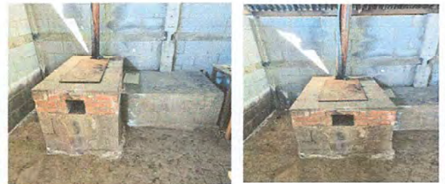
Foto 4: MODULO II Suministro e instalación de azulejo a la plancha
