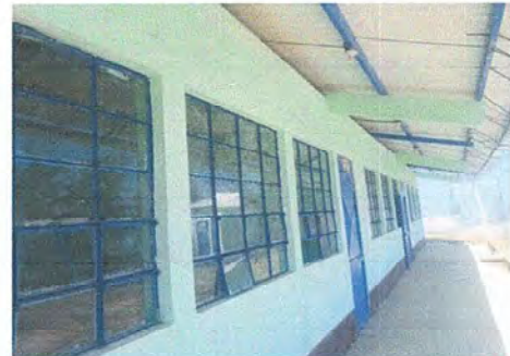
Foto 6: Pintura de muro exterior e interior
