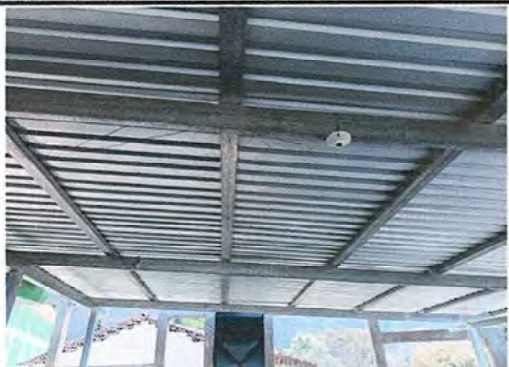
Foto 7, Modulo 2: Reparación de cableado eléctrico y Reparación de lámparas
