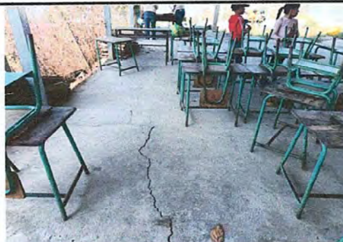
Foto 6, Módulo 2: Sustitución de piso de cemento líquido por piso cerámico
