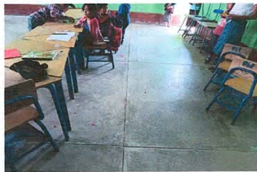
Foto 2, Módulo 1: Sustitución de piso de torta de concreto por piso cerámico
