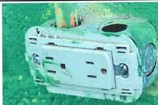
Foto 5, Módulo 1: Sustitución de tomacorrientes dobles
