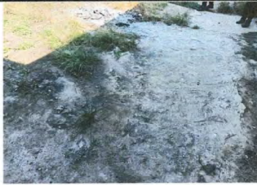
Foto 8, Patio: Reparación de plancha de concreto de patio
