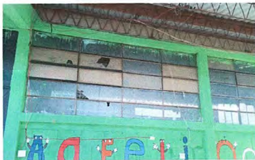
Foto 1, Módulo 1: Sustitución de vidrios
