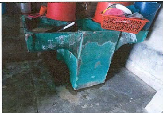
Foto 3, Módulo 1: Sustitución de pila de cemento de dos lavaderos por pila plástica
