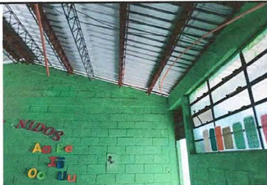
Foto 9, Pintura General: PINTURA EN MUROS INTERIORES Y EXTERIORES
