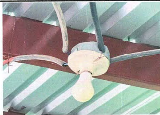
Foto 4, Módulo 1: Reparación de cableado eléctrico y Reparación de lámparas
