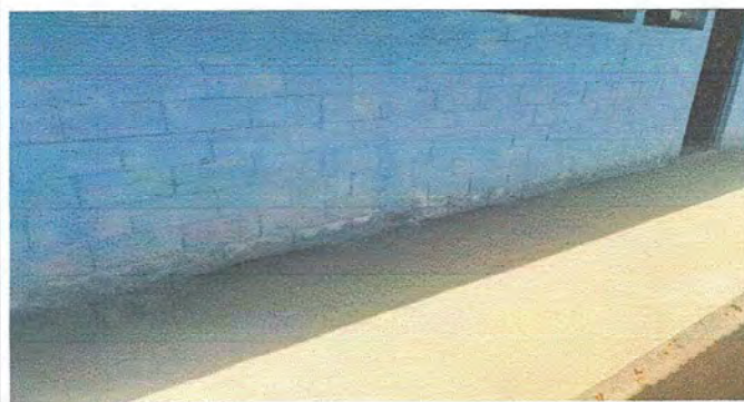
Foto 5, Modulo 1: Pintura General: Pintura en muros exteriores e interiores
