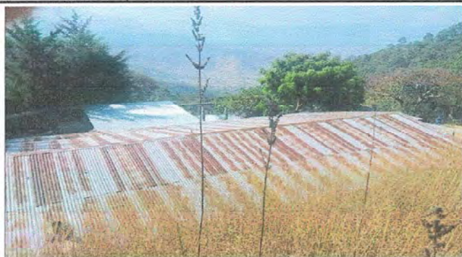
Foto 1, Modulo 1: Sustrucción de lamina, por lámina troquelada Aluzinc calibre 26
