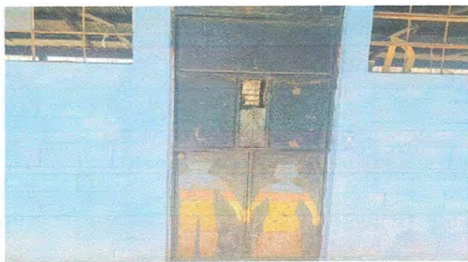
Foto 4, Modulo 1: Mantenimiento de estructura de puerta (lijado, cambio de tubo, cepillado, sujeciones, aplicación de pintura)
