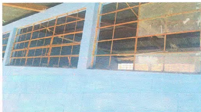
Foto 3, Modulo 1: Sustrucción de estructura de metal de ventana
