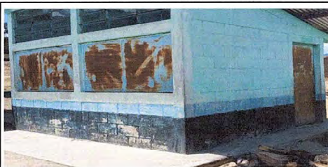
FOTO 10 MODULO 4: Pintura en muros exteriores e interiores
