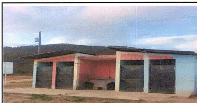
FOTO 6 MODULO 2: Mantenimiento a estructura de puerta(lijado,cambio de tubo, cepillado,sujecciones,aplicación de pintura)
