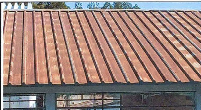
FOTO 1 MODULO 1: sustitución de lámina, por lámina troquelada aluzinc calibre26
