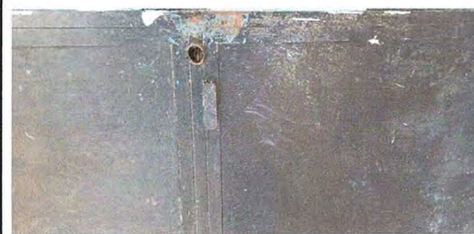
FOTO 3 MODULO 1: Sustitución de chapa
