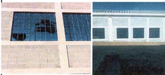
FOTO 7 MODULO 3: Instalación de balcon de hierro en ventana
