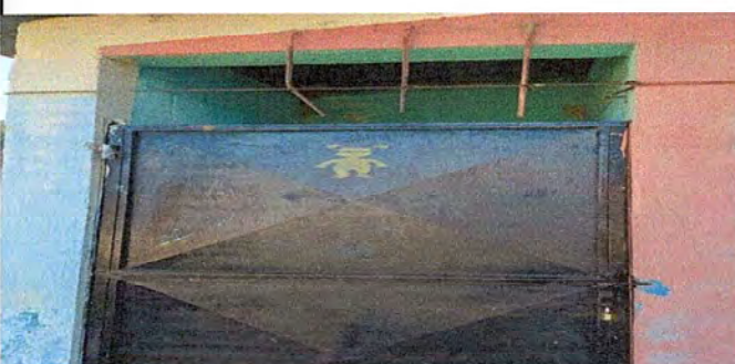
FOTO 5 MODULO 2: Sustitución e instalación de sobre luz en puertas de baños.
