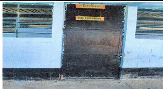
FOTO 4 MODULO 1: Mantenimiento a estructura de puerta(lijado,cambio de tubo, cepillado,sujecciones,aplicación de pintura)
