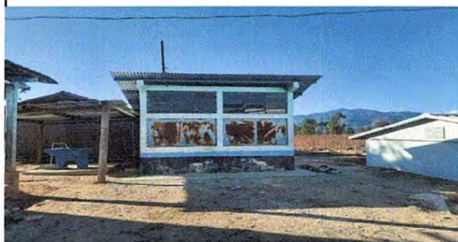
FOTO 8 MODULO 4: Mantenimiento a estructura de metal de ventana.
