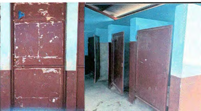
Foto 5: Módulo 1 Mantenimiento a estructura de puerta (lijado, cepillado, aplicación de pintura)
