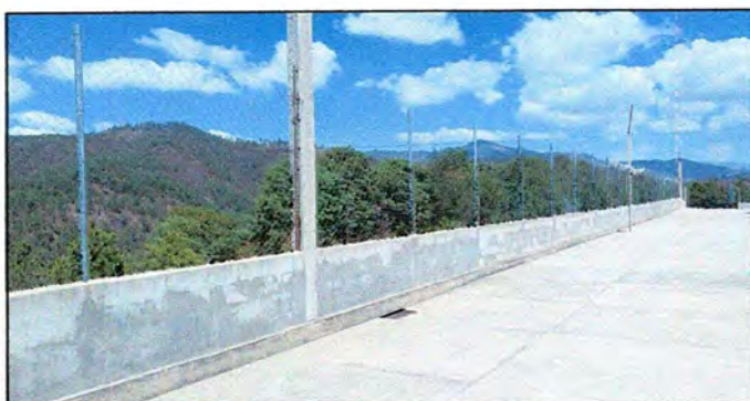
Foto 11: Reparación de tubo HG y malla galvanizada
