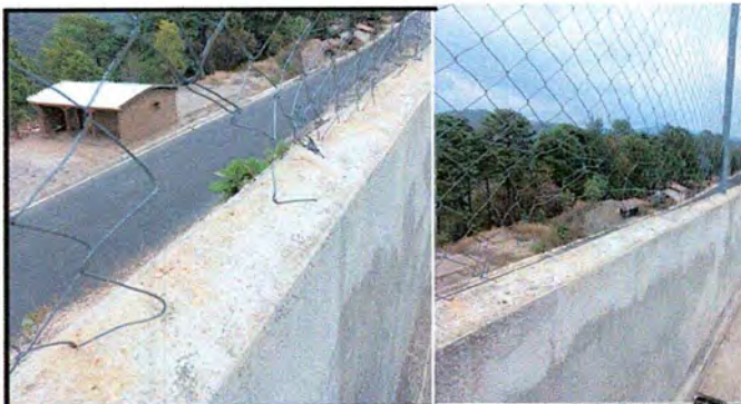
Foto 12: Reparación de tubo HG y malla galvanizada
