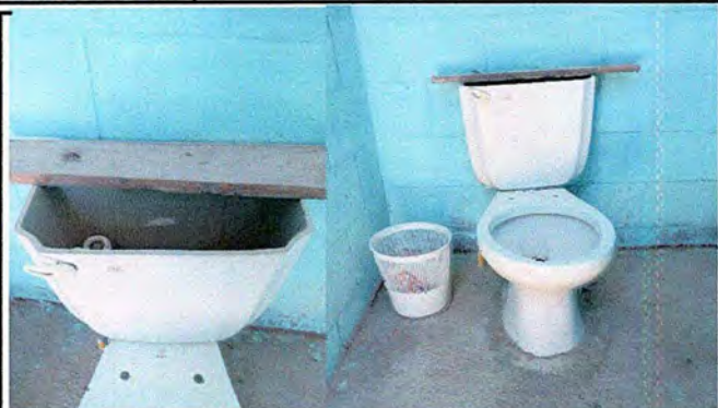
Foto 1: Módulo 1 Sustitución de Inodoros
