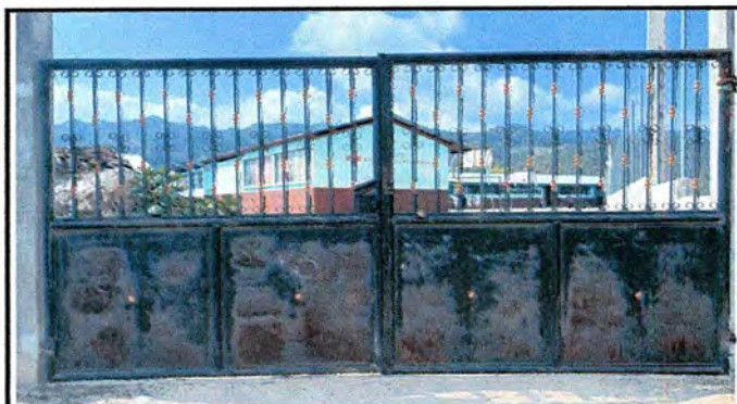
Foto 9: Mantenimiento a porton de metal
