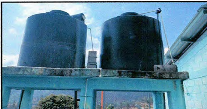
Foto 10: Sustitución de depositos de agua 2500L
