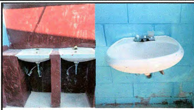
Foto 2: Módulo 2 Sustitución de Lavamanos
