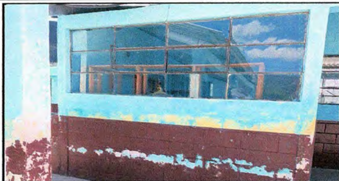
Foto 7: Módulo 2 Suministro e instalación de balcon de hierro en ventanas
