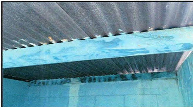
Foto 4: Módulo 1 Sustitución de soporte de madera por metal
