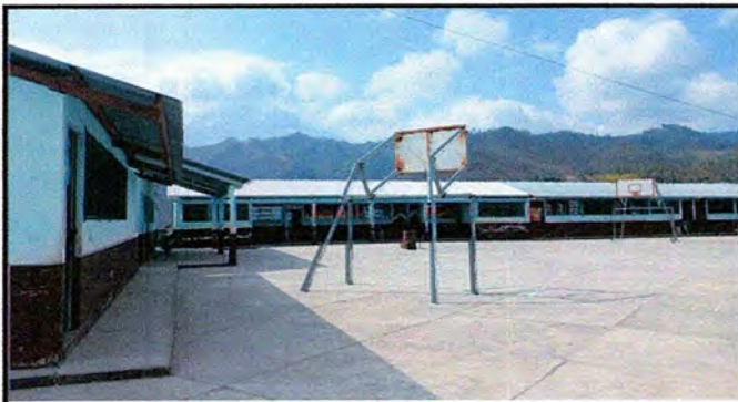
Foto 8: Módulo 3 Pintura en muros interiores y exteriores
