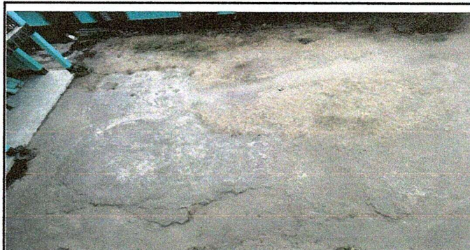
Foto 2: Reparación de planchas de concreto de patio.
