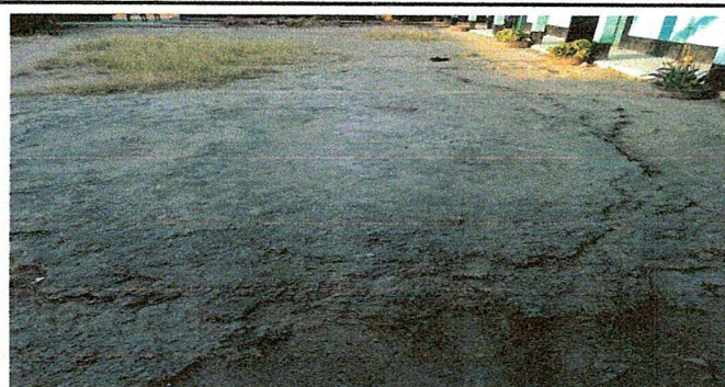
Foto 3: Reparación de planchas de concreto de patio.
