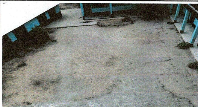
Foto 1: Reparación de planchas de concreto de patio.
