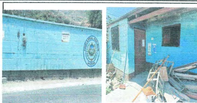
Foto 8: pintura en muro interior y exterior
