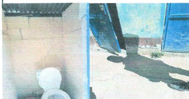
Foto 4: Baños: sustrucción de inodoro , sustrucción de accesorios de inodoros
