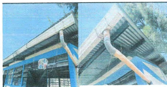
Foto 6: desinstalacion y sustrucción de canal Pvc
