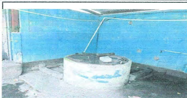
Foto 7: area de pozo. Desinstalacion e instalacion de bomba, mantenimiento
