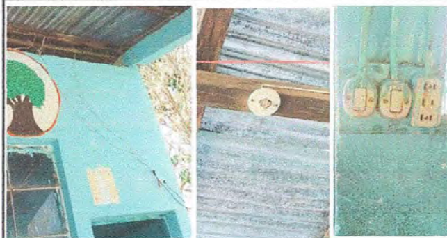
Foto 4: Módulo 1 Reparación de cableado eléctrico.
