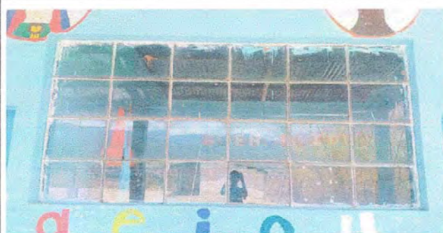
Foto 3: Módulo 1. Suministro e instalación de balcones.
