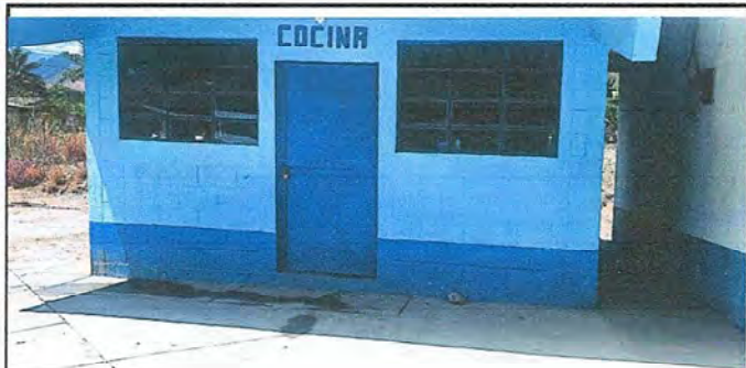
Foto 1, COCINA: Mantenimiento a estructura de puerta (lijado, cambio de tubo, cepillado, sujeciones, aplicación de pintura)
