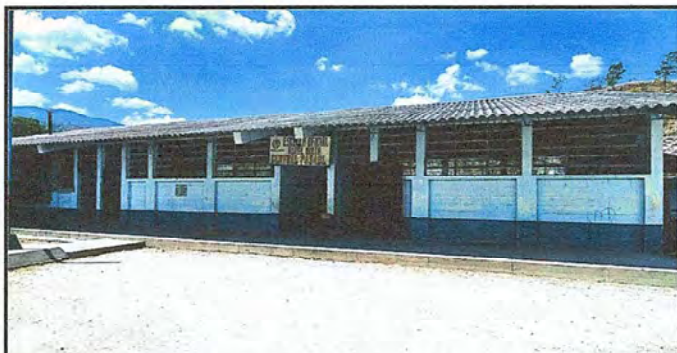
Foto 3, MODULO 1: Mantenimiento a estructura de puerta (lijado, cambio de tubo, cepillado, sujeciones, aplicación de pintura).
