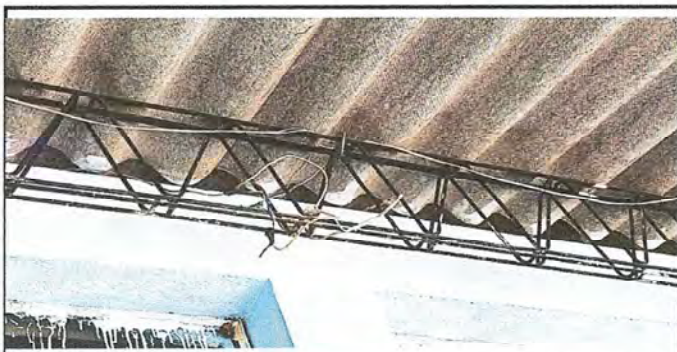
Foto 5, MODULO 1: Reparación de cableado eléctrico.
