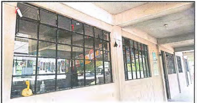
Foto 10, MODULO 3: Suministros e instalación de balcones de metal.
