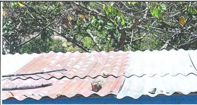
Foto 7, MODULO 3: Sustrucción de lámina, por lámina troquelada aluzinc calibre 26 y mantenimiento a estructura soporte de metal.
