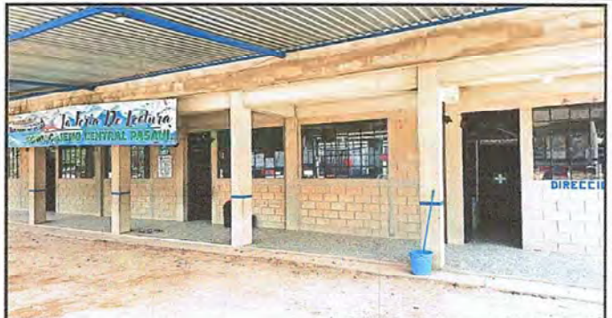
Foto 8, MODULO 3: Mantenimiento a estructura de puerta (lijado, cambio de tubo, cepillado, sujeciones, aplicación de pintura)
