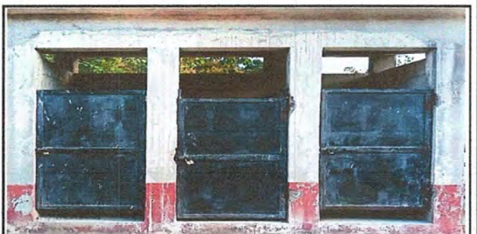
Foto 12, BAÑOS: Mantenimiento a estructura de puerta (lijado, cambio de tubo, cepillado, sujeciones, aplicación de pintura) a puertas servicios sanitarios.
