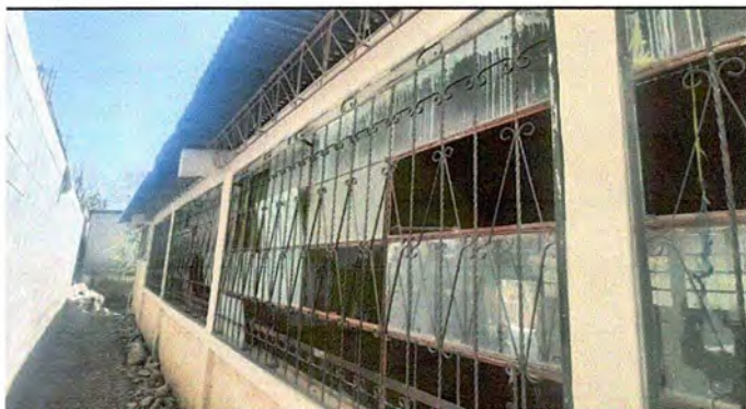
Foto 3: Módulo 1: Mantenimiento a estructura metálica de ventana
