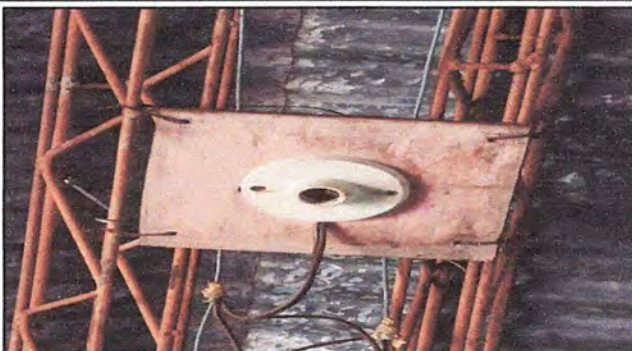
Foto 8: Módulo 1: Sustitución de Focos
