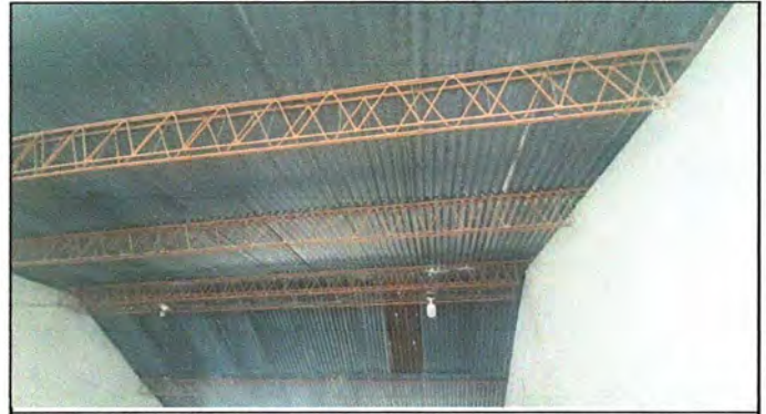
Foto 2: Módulo 1: Mantenimiento a estructura de soporte de metal
