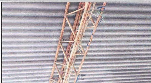
Foto 7: Módulo 1: Sustitución de Estructura de soporte de metal
