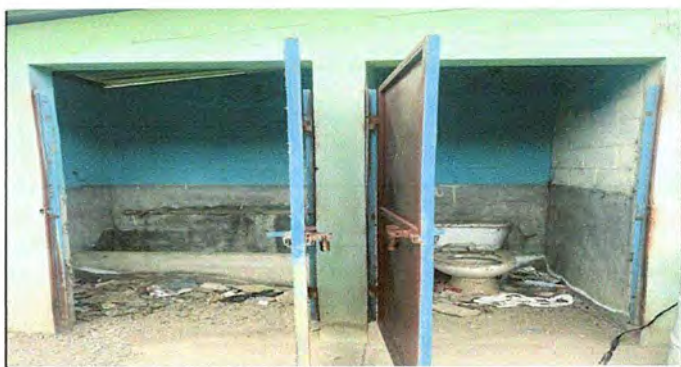
Foto 5: Módulo 2: Sustitución de Sanitarios
