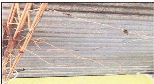
Foto 9: Módulo 1: Sustitución de ducto eléctrico
