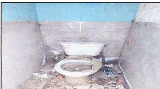
Foto 10: Sustitución de Inodoro
