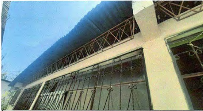
Foto1: Módulo 1: Sustitución de lámina por lamina troquelada
