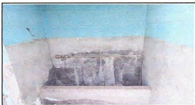
Foto 11: Módulo 2: Sustitución de Mingitorio
