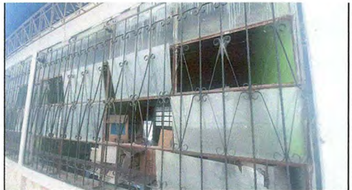
Foto 4: Módulo 1: Mantenimiento a balcones de metal
