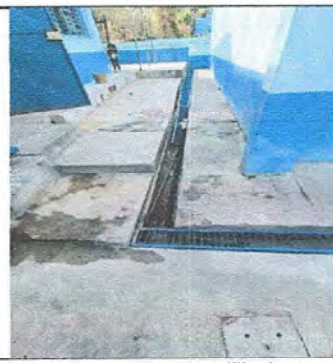
Foto 6: ÁREA EXTERIOR. Reparación de rejilla de cuneta
