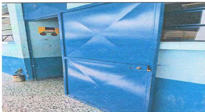
Foto 3: MÓDULO 1. Mantenimiento de puertas de metal. Sustitución de Chapas.
