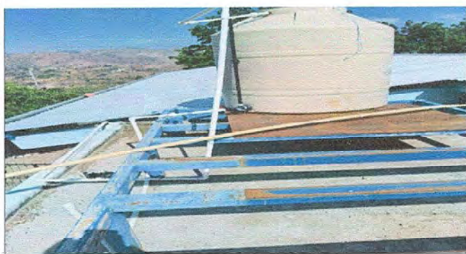
Foto 5: BAÑOS. Sustitución de tubería Línea principal.
