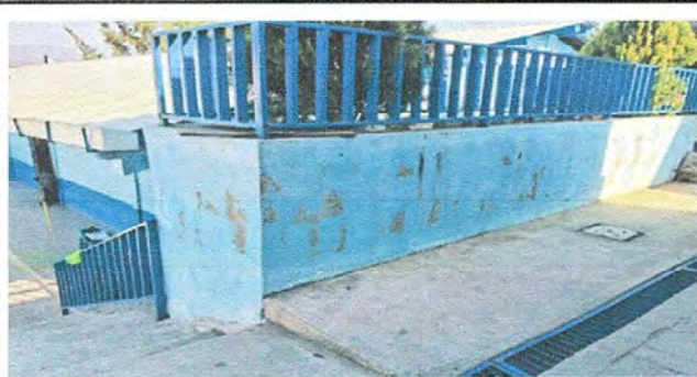
Foto1: PINTURA GENERAL. Pintura en muros exteriores e interiores
