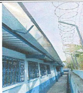
Foto 8: MÓDULO 4. Sustitución de canales de metal por PVC
