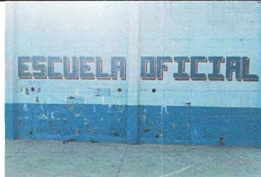
Foto 2: PINTURA GENERAL. Pintura en muros exteriores e interiores
