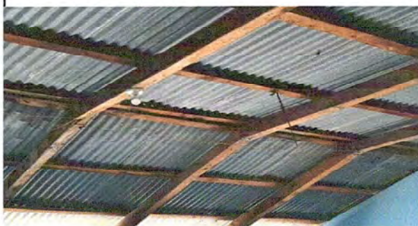
Foto 2: MÓDULO 1 Sustitución de estructura de soporte de madera, por metal
