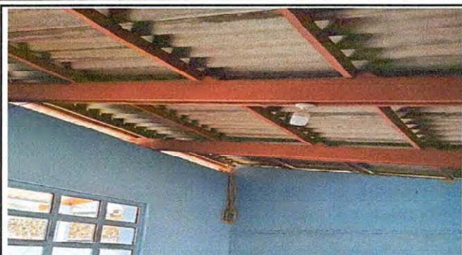
Foto 7: Sistema Eléctrico. Módulo 2 Sustitución de ducto eléctrico + accesorios
