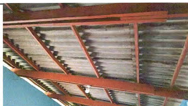
Foto 6: MÓDULO 1 Sustitución de estructura de soporte de madera, por metal
