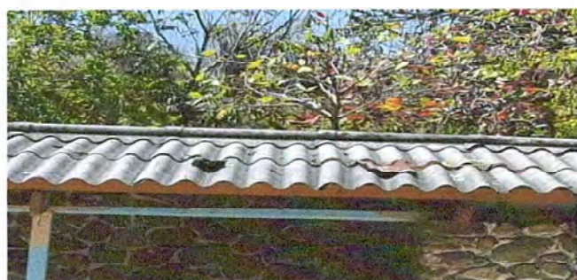
FOTO 5: MÓDULO 2 Sustitución de duralita a lámina troquelada aluzinc, calibre 26.
