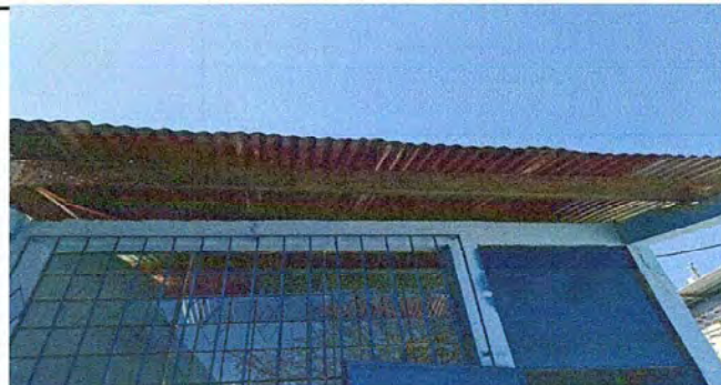
Foto 8: BODEGA Sustitución de lamina a lámina troquelada alizinc, calibre 26.
