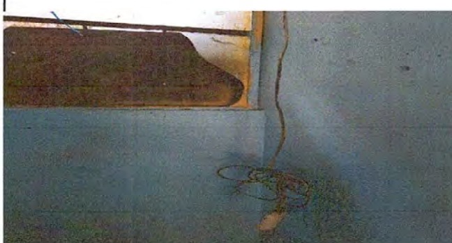
Foto 4: MÓDULO 1. Sistema Eléctrico. Módulo 1 Sustitución de apagadores.
