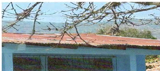
FOTO 1: MÓDULO 1 Sustitución de lámina a lámina troquelada aluzinc, calibre 26.
