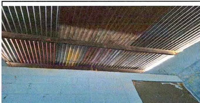
FOTO 9. BODEGA. Mantenimiento a estructura de soporte de metal
