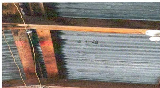
Foto 3: MÓDULO 1 Sustitución de ducto eléctrico + accesorios
