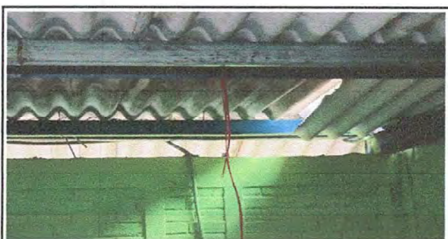
MODULO 2 sustitucion de lamina por lamina troquelada aluzinc calibre 26
