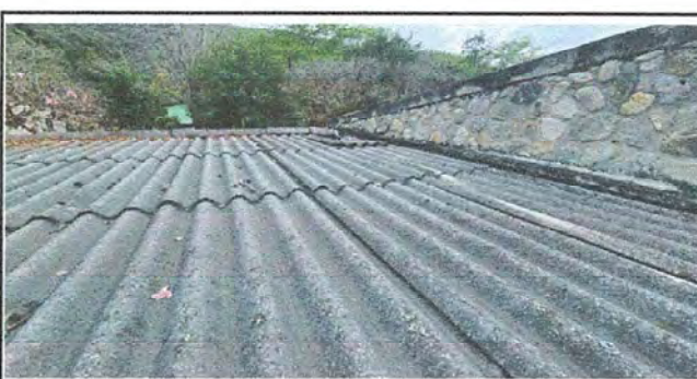
MODULO 2 sustitucion de lamina por lamina troquelada aluzinc calibre 26
