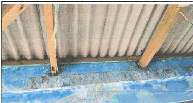
MODULO 1 sustitucion de estructura de madera por metal
