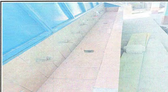
Foto 14: MÓDULO 1 Mantenimiento a reposaderas.
