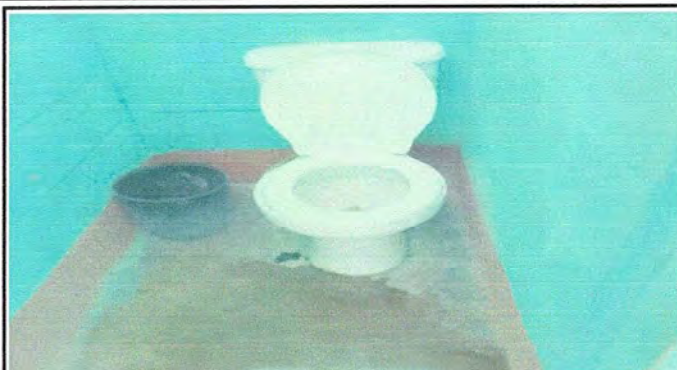
Foto 13: MÓDULO 1 Sustrucción inodoro
