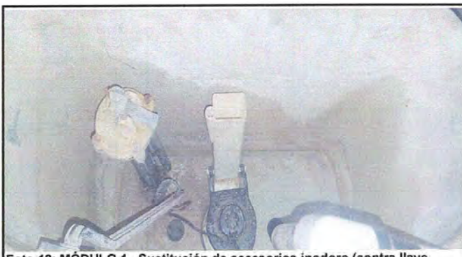
Foto 12: MÓDULO 1 Sustitución de accesorios inodoro (contra llave, tubo de abasto y tanque)
