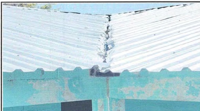
Foto 10: MÓDULO 1 Mantenimiento a estructura de soporte de metal.
