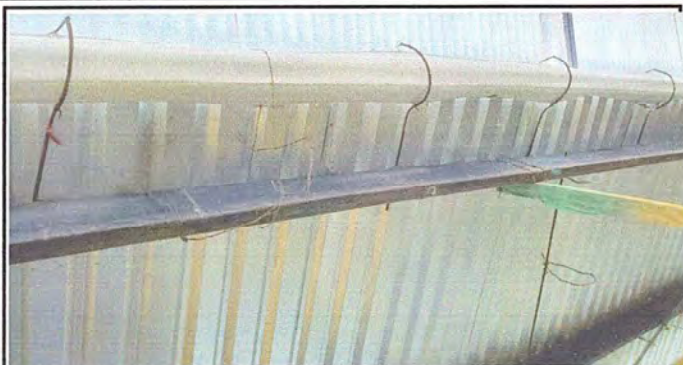
Foto7: MÓDULO 1 Sustitución de Soporte o pescante de metal para canal.
