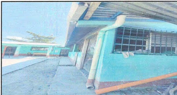
Foto 8: MÓDULO 1 Sustitucion de bajada de agua pluvial tubo PVC 3"
