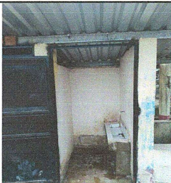
Foto1: Módulo 1. Sustrucción de mingitorio de concreto por mingitorio de loza (incluye demolición)
