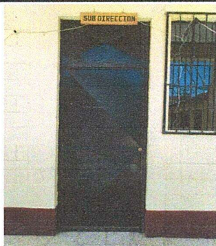
Foto 3: Módulos 3. Suministro e instalación de puerta de metal tipo reja
