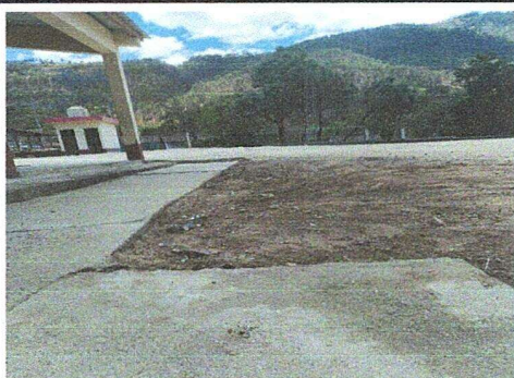
Foto 5: Patio: Reparación de planchas de concreto de patio
