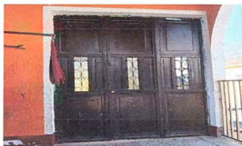
MODULO 1: Foto No. 1 Aplicación de Pintura interna y externa en Portón.
