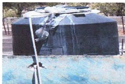
MÓDULO 2: Foto No. 8 Sustitución de deposito de agua.
