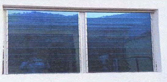
MÓDULO 3: Foto No. 11 Instalación de Balcones.
