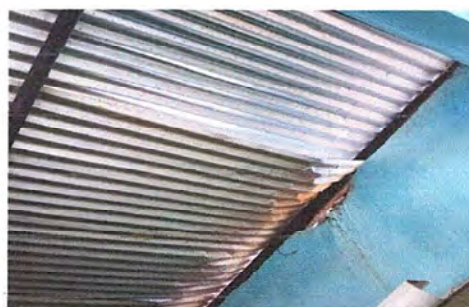
MODULO 2: Foto No. 4 Sustitución de lamina troquelada y fijación de tornillos, desinstalación de lamina existentes.
