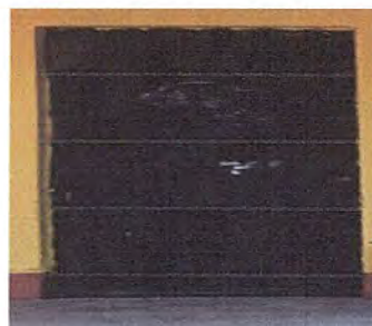
MODULO 1: Foto No. 2 Aplicación de Pintura en Puertas.
