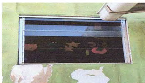
MODULO 1: Foto No. 3 Sustitución de Vidrios.
