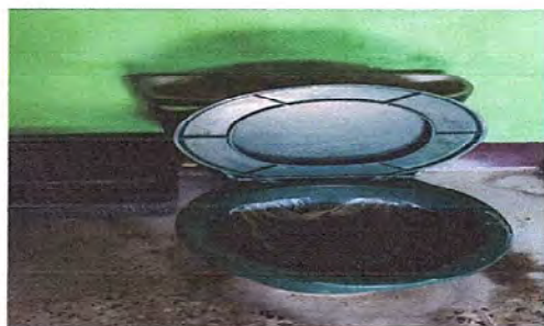
MÓDULO 2: Foto No. 7 Sustitución de sanitarios.
