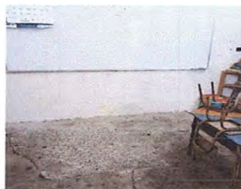
MÓDULO 3: Foto No. 10 Sustitución de piso.
