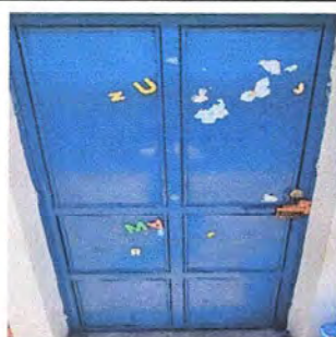
MÓDULO 3: Foto No. 9 Mantenimiento a estructura de puertas
