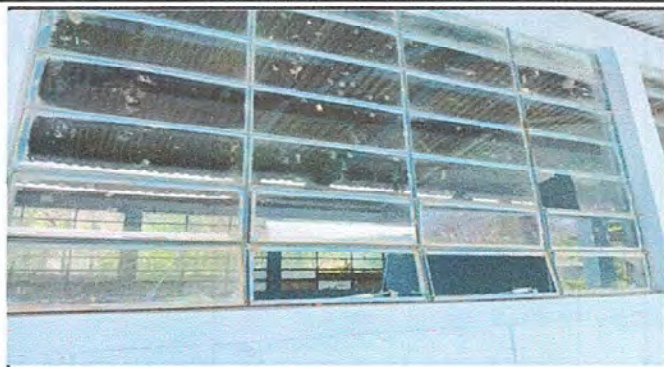
Foto 2 . Módulo 1 Colocación de balcones
