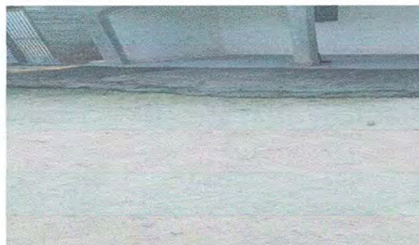
Modulo 1. Foto 8: Sustitución de patio
