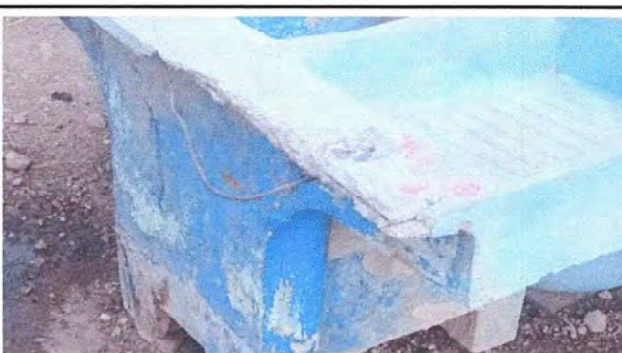
MODULO 1 Sustitución de pila de cemento de dos lavaderos.
