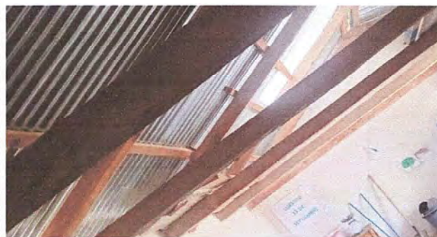
MODULO 1 sustitucion de estructura de madera por estructura de metal
