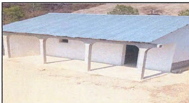
MODULO 1 aplicacion de pintura en muros exteriores e interiores
