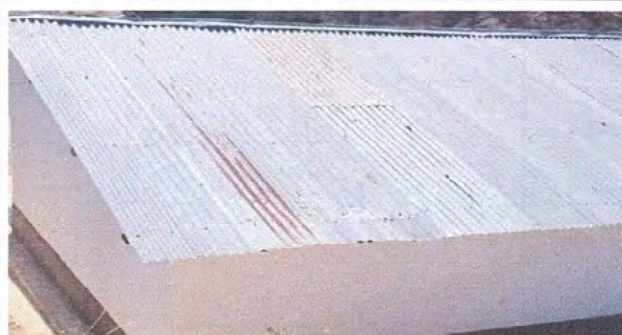
MODULO 1 instalacion de canales y bajadas de agua pluvial
