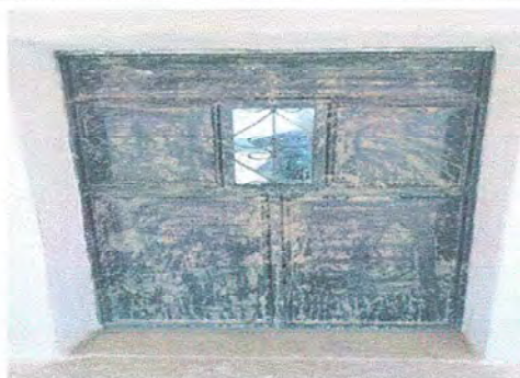
Modulo 1. Foto 7: Fabricación e instalación de puerta de metal
