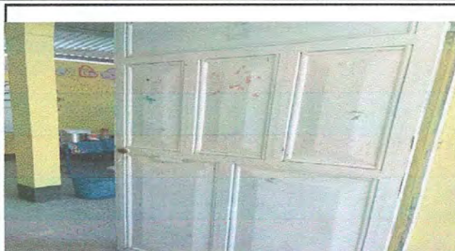
Foto 2 Modulo 1: mantenimiento a estructura de puerta (lijado, cambio de tubo, cepillado, sujeciones, aplicación de pintura).
