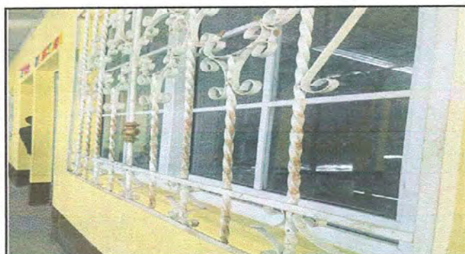
Foto 3 Modulo 1: Mantenimiento a balcones de metal.
