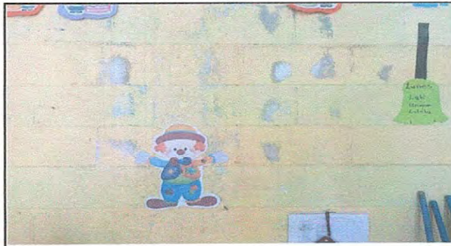
Foto 8 Modulo 1: Pintura de muros exteriores e interiores.
