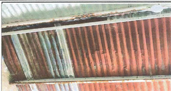
Foto 1 Modulo 1: Sustitución de lámina por lámina troquelada calibre 26, sustitución de estructura de soporte de metal.
