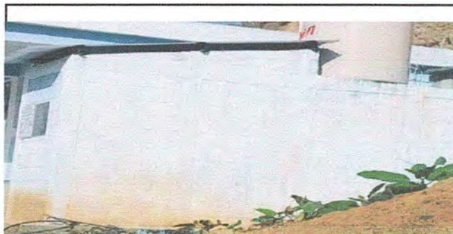
Foto 24: Pintura en muros exteriores e interiores
