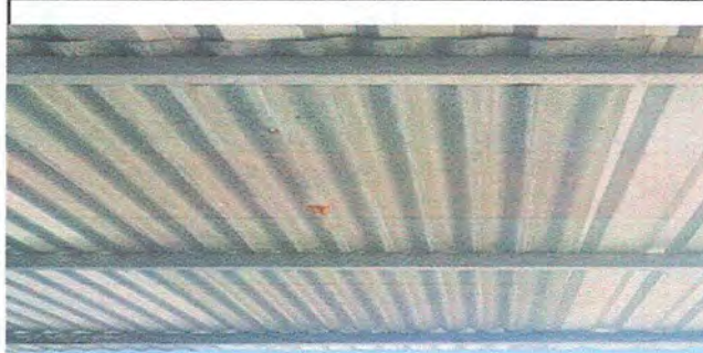
Foto 12: Módulo 2. Sustitución de lámina por lámina troquelada
