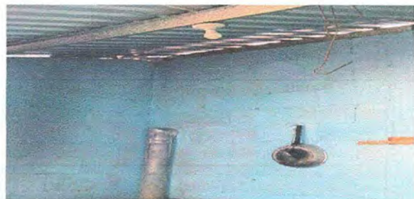
Foto 16: Módulo 3. Sustitución de focos ahorradores
