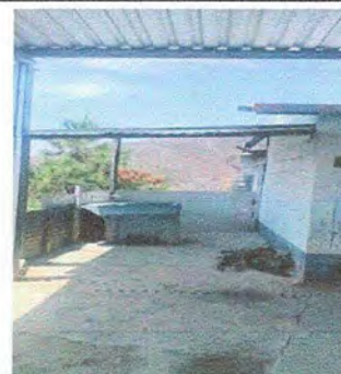
Foto 18: Módulo 3. Sustitución de pila de cemento de dos lavaderos
