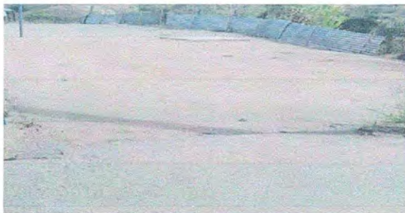
Foto 19: PATIO. Reparación de torta de concreto
