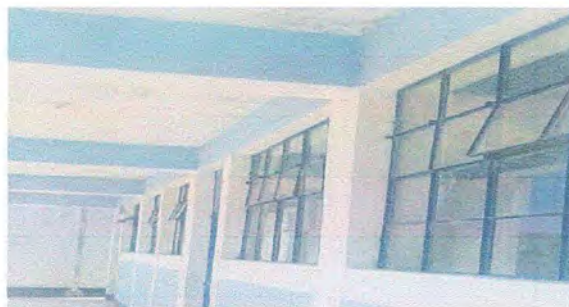
Foto 2: Módulo 1. Fabricación e instalación de balcones de hierro en ventana
