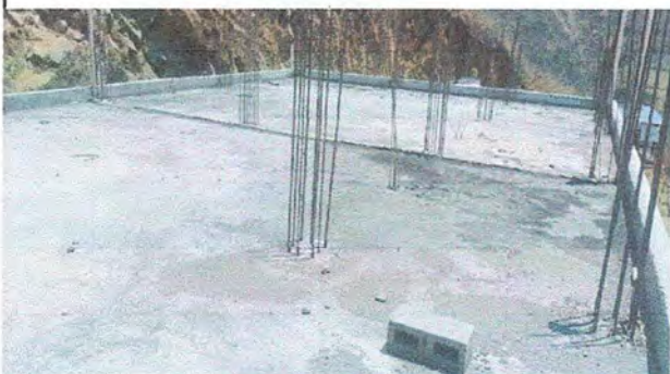
Foto 3: Módulo 1. Impermeabilización de losa
