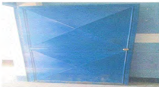
Foto 1: Módulo 1. Mantenimiento a estructura de puerta
