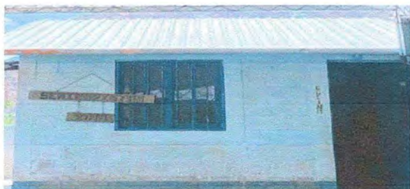
Foto 23: Pintura en muros exteriores e interiores
