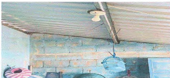
Foto 17: Módulo 3. Sustitución de plafoneras
