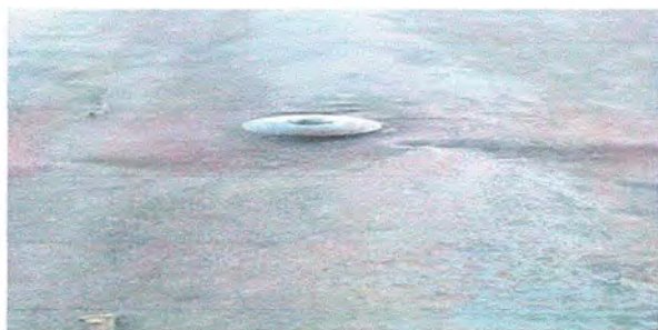
Foto 5: Módulo 2. Sustitución de elementos de fijación (tornillos)
