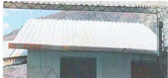
Foto 14: Módulo 3. Sustitución de canal de metal
