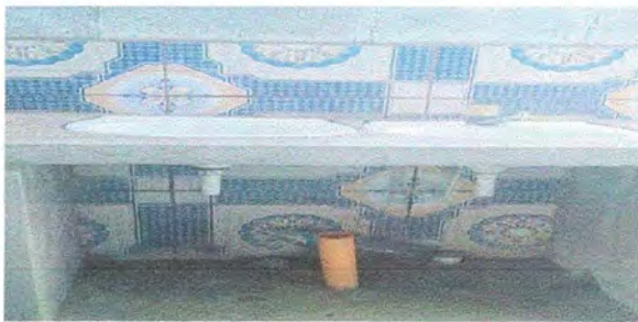
Foto 15: Módulo 3. Sustitución de lavamanos
