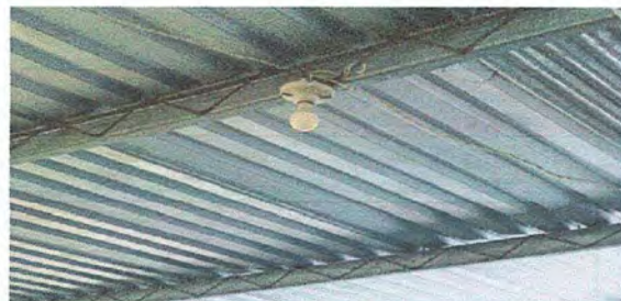
Foto 10: Módulo 2. Sustitución de plafoneras
