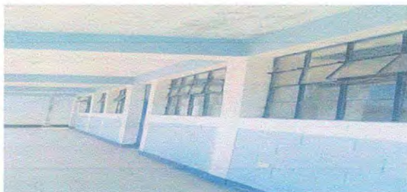
Foto 21: Pintura de muros exteriores e interiores
