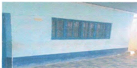
Foto 22: Pintura en muros exteriores e interiores
