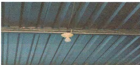
Foto 9: Módulo 2. Sustitución de focos ahorradores
