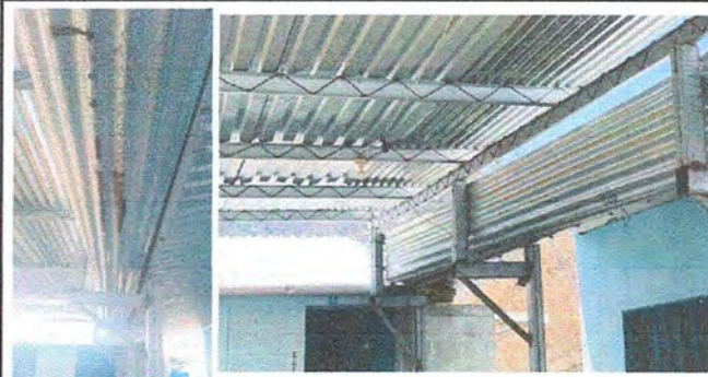
Foto 4: Módulo 2. Sustitución de canal de metal
