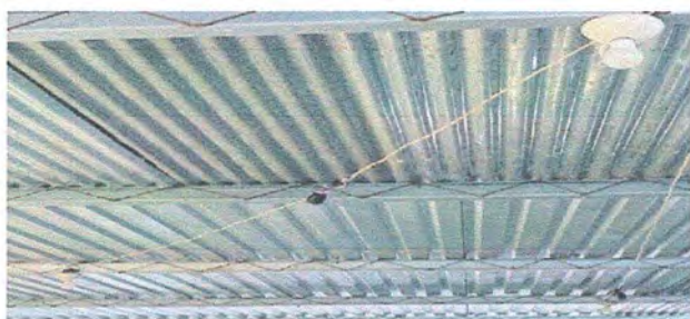
Foto 11: Módulo 2. Reparación de cableado eléctrico
