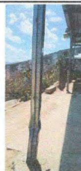
Foto 6: Módulo 2. Sustitución de parales de metal
