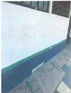
Foto 1: Módulo 1. Aplicación de pintura en muros internos y externos
