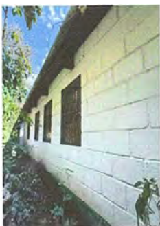
Foto 3: Modulo 2. Aplicación de pintura en muros interiores y exteriores
