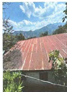
foto 4: Módulo 2. Instalación de lamina troquelada calibre 36
