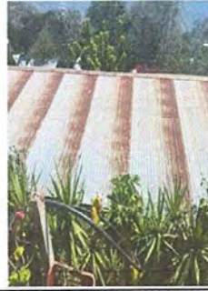
Foto 2: Módulo 1. Instalación de lámina por lámina troquelada calibre 26
