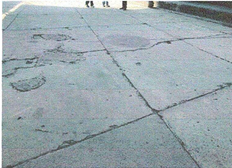
Foto1: PATIO Reparación de planchas de concreto de patio.
