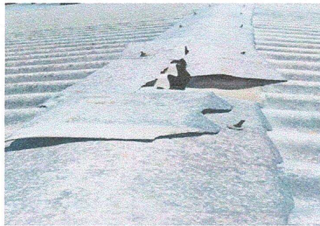
Foto 2: MODULO 1 Sustitución de capote de lámina para lámina troquelada
