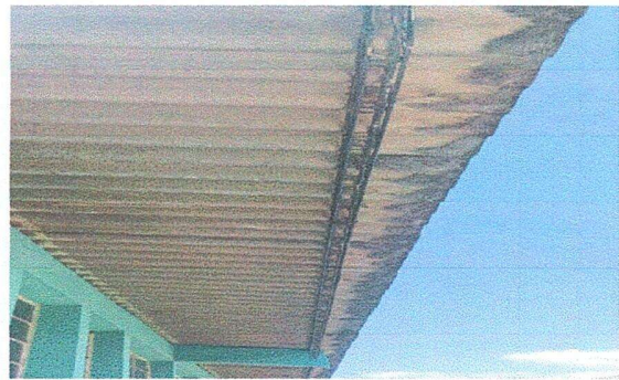
Foto 3: MODULO 1 Sustitución de estructura de soporte de metal, por metal.
