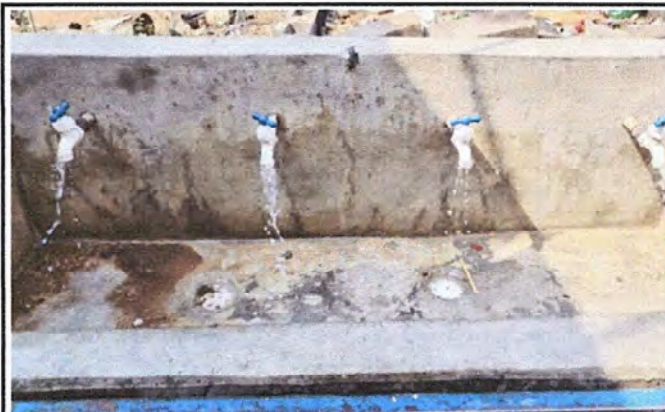
FOTO 4: MODULO 1: Sustitución de llave de chorro.
