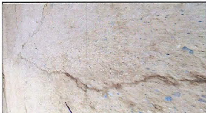
FOTO 1: MODULO 1: Reparación de plancha de concreto de patio.
