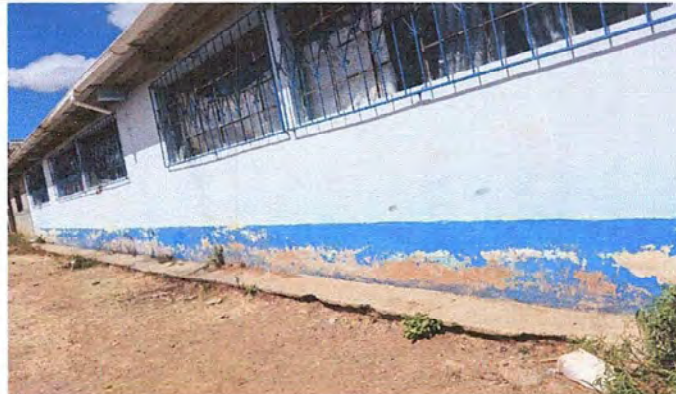
FOTO 2: MODULO 1: Reparación de banqueta de concreto.
