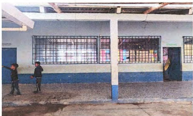
FOTO 3: MODULO 1: Pintura general.
