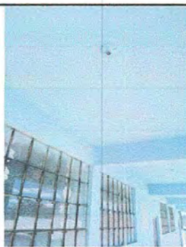
Foto 17: Módulo 4 sustitución de focos ahorradores
