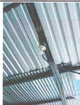
Foto 8: Módulo 2. Sustitución de plafoneras y focos ahorradores
