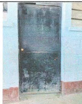
Foto 10: Módulo 3. Mantenimiento de puertas de metal
