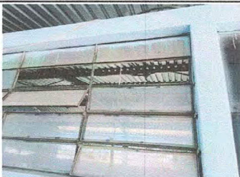
Foto7: Módulo 2 Sustitución de vidrios y mantenimiento de estructura de metal de ventana
