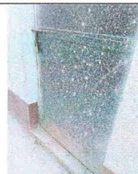
Foto 6: Módulo 2. Mantenimiento de puertas de metal
