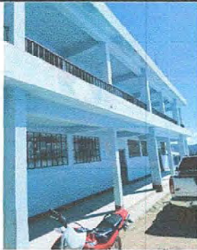
Foto13: Módulo 4. aplicación de pintura en muros exteriores e interiores
