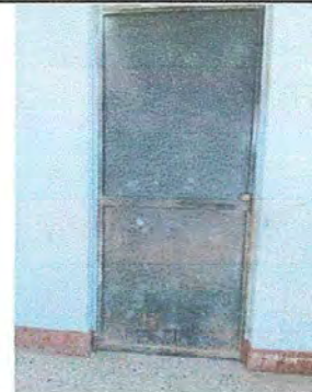
Foto 14: Módulo 4 Mantenimiento de puertas de metal
