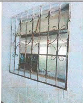
Foto 3: Módulo 1. Sustitución de vidrios, mantenimiento de balcones y mantenimiento de estructura de metal de ventana
