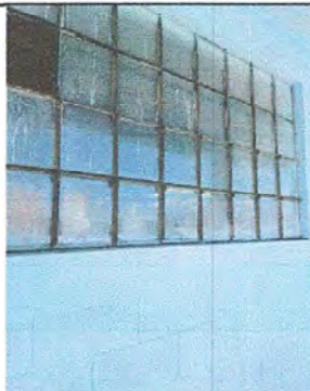
Foto 15: Módulo 4. Sustitución de vidrios y mantenimiento de estructura de metal de ventana
