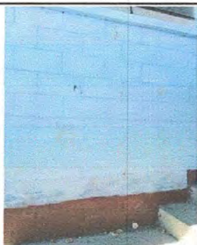
Foto 9: Módulo 3. Aplicación de pintura en muros exteriores e interiores
