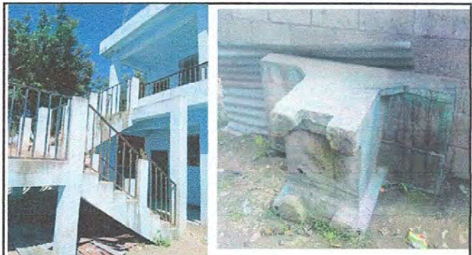
Foto 16: Módulo 4. Mantenimiento de barandas y sustitución de pila
