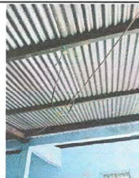
Foto 4: Módulo 1 Sustitucion de focos, plafoneras e instalación de luz
