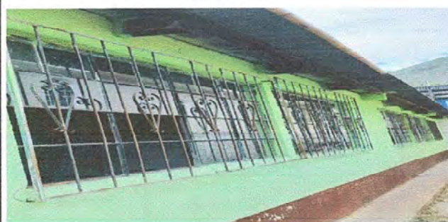
Foto 5: Mantenimiento a balcones de metal
