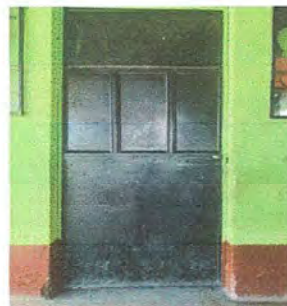
Foto 4: Mantenimiento a estructura de puerta (lijado, aplicación de pintura)
