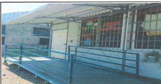
Foto 5: Módulo 3 sustitución de chapa.
