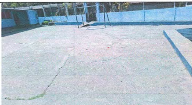
Foto 3: Módulo 2 Parte 1 reparación de patio.
