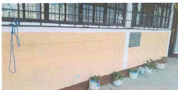
Foto 9 Módulo 2: Sustrucción de tomacorriente y apagadores
