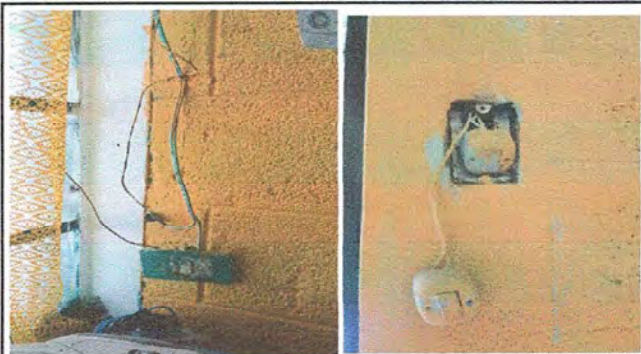
Foto 7 Módulo 1: Sustrucción de unidades de apagadores e interruptores
