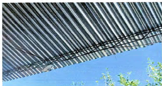
Foto 3 Módulo 1: Sustitución de plafoneras, focos y cableado + accesorio
