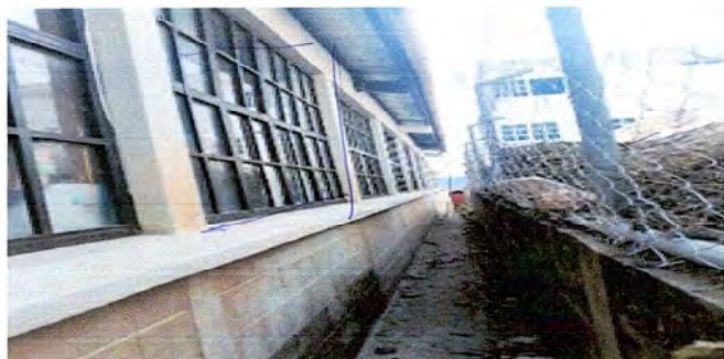
Foto 1 Módulo 1: Sustitución de ventana
