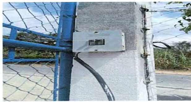
Foto 4 Mdulo 1: Sustitución de tablero de flipones
