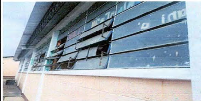
Foto 2 Módulo 1: Sustitución de balcon
