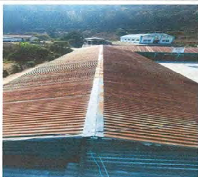
Foto 3: Sustitución de lamina por lámina troquelada aluzinc calibre 26 Modulo 2
