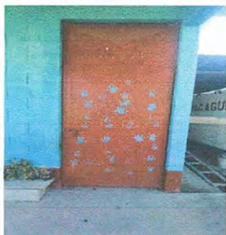
Foto 7: Mantenimiento a estructura de puerta (lijado, cambio de tubo, cepillado, sujeciones, aplicación de pintura) Modulo 2
