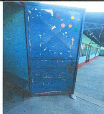
Foto 2: Mantenimiento a estructura de puerta (lijado, cambio de tubo, cepillado, sujeciones, aplicación de pintura) Modulo 1
