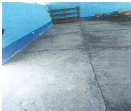
Foto 1: Sustitución de piso de cemento líquido por piso cerámico. Modulo 1
