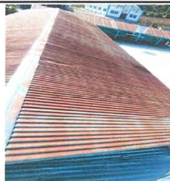
Foto 4: Sustitución de capote de lámina para lámina troquelada. Modulo 2
