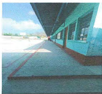
Foto 11: Pintura en muros interiores y exteriores. Pintura General
