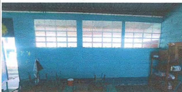
Foto 9: Pintura en muros interiores y exteriores. Pintura General
