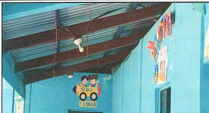
Foto 13: MÓDULO 1 Sustitución de Ducto Eléctrico
