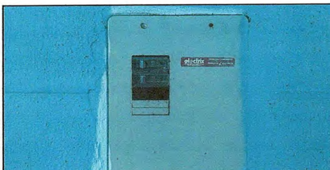
Foto 11: MÓDULO 1 Sustitución de tablero de flipones
