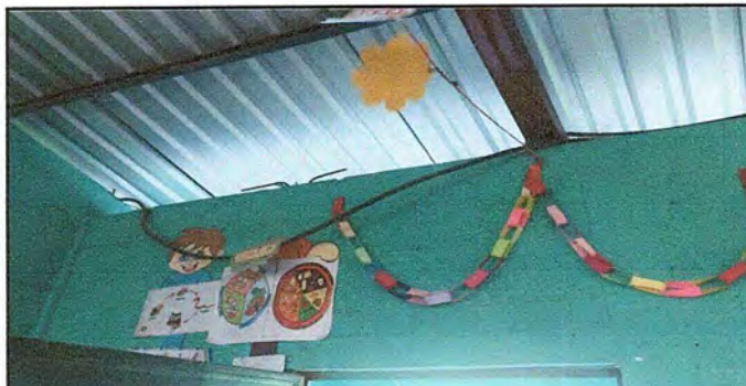
Foto 12: MÓDULO 1 Reparación de cableado eléctrico
