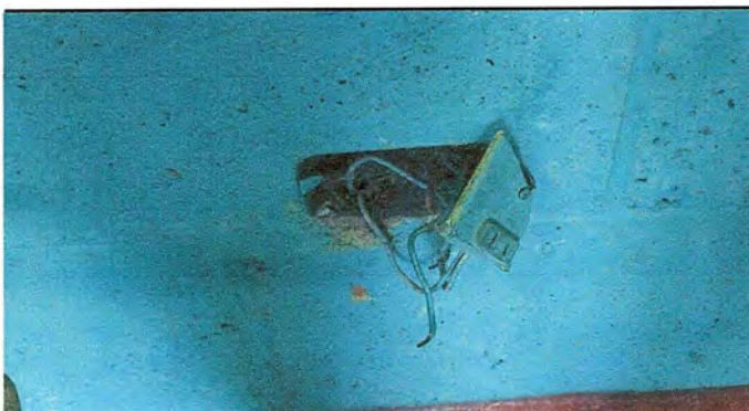
Foto 9: MÓDULO 1 Sustitución interruptores dobles
