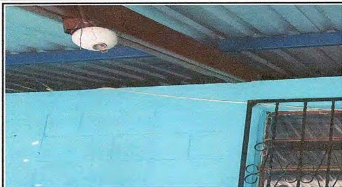
Foto7: MÓDULO 1 Sustitución de plafoneras
