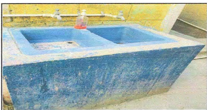
Foto 5: MÓDULO 2 Sustitución de lavamanos
