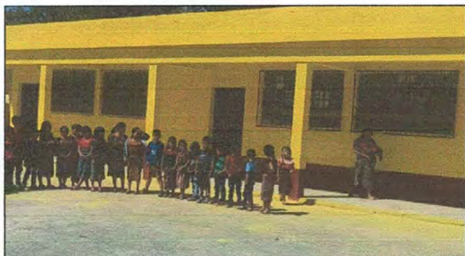
Foto 9: MÓDULO 2 Mantenimiento a balcones de metal.
