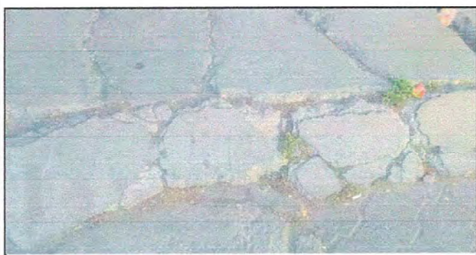
Foto 11: MÓDULO 2 Reparación de Planchas de concreto de patio.
