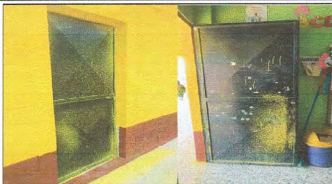
Foto 7: MÓDULO 2 Mantenimiento a estructura de puerta (lijado, cambio de tubo, cepillado, sujeciones, aplicación de pintura).
