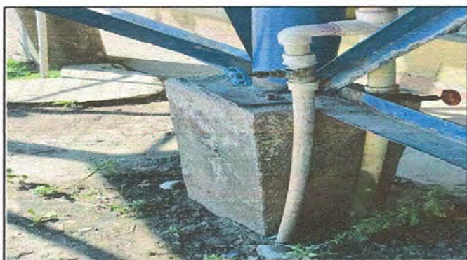
Foto 3: MÓDULO 1 Sustitución de Tubería principal de PVC para agua Potable
