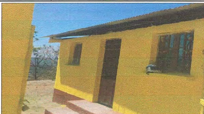
Foto 20: MÓDULO 3 Suministro e instalación de balcón de hierro en ventana.
