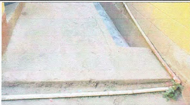
Foto 13: MÓDULO 3 Sustitución de tubería línea principal.
