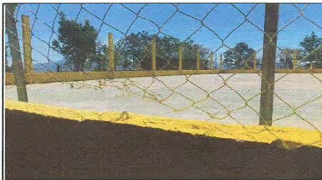
Foto 22: MÓDULO 4 Reparación de tubo HG y malla galvanizada.
