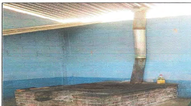
Foto 16: MÓDULO 3 Sustitución de Chimenea de Metal.
