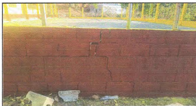
Foto 12: MODULO 2 Reparación de muro de contención
