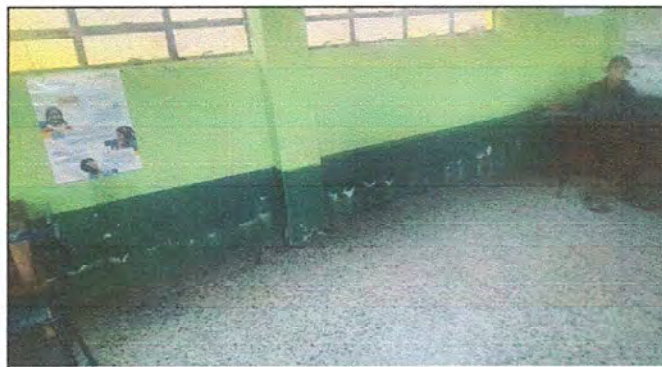
Foto 10: MÓDULO 2 Pintura en muros exteriores e interiores.
