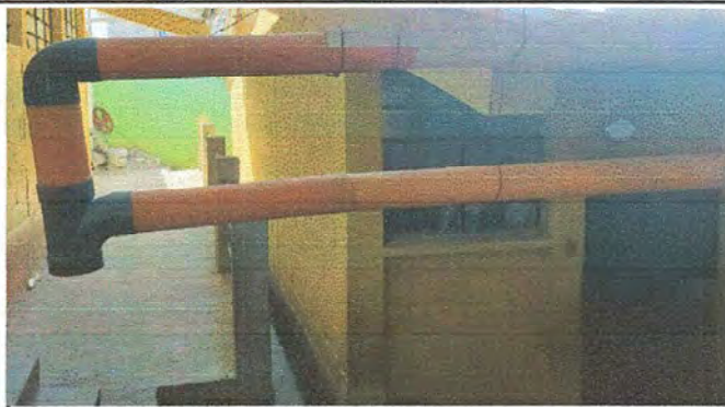
Foto 2: MÓDULO 1 Sustitución de Tubería PVC línea Principal Aguas Pluviales
