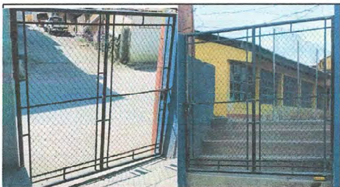
Foto 21: MÓDULO 4 Sustitución de Porton
