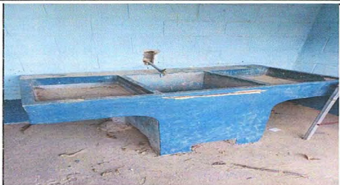
Foto 8: Módulo 2: Sustitución de pila de cemento de dos lavaderos.
