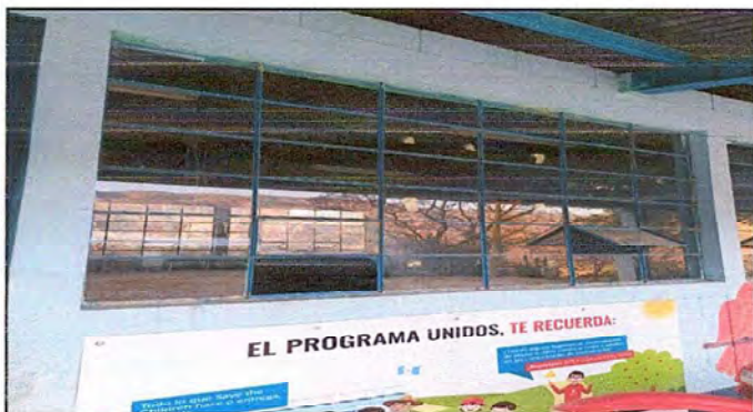
Foto 3: Módulo 1: Fabricación e instalación de ventanas de metal.
