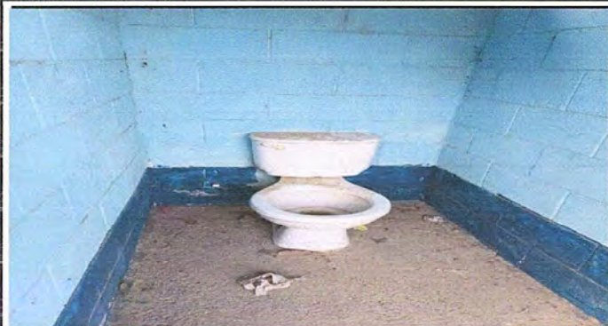
Foto 7: Módulo 2: Sustitución de inodoros.
