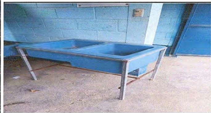
Foto 9: Módulo 2: Sustitución de lavamanos.
