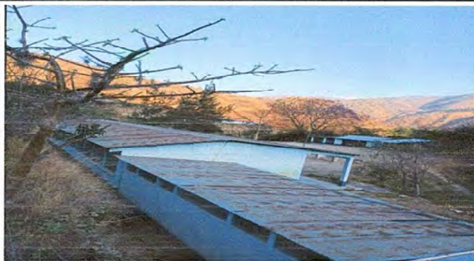
Foto 1 : Módulo 1: Sustitución de lámina y mantenimiento de soporte de metal.
