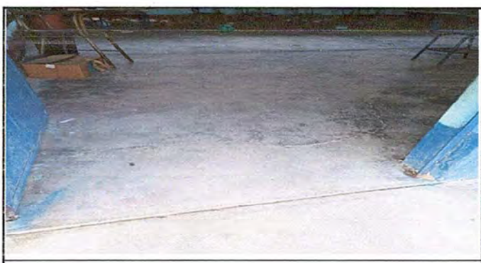
Foto 5: Módulo 1: Reparación de piso de concreto.
