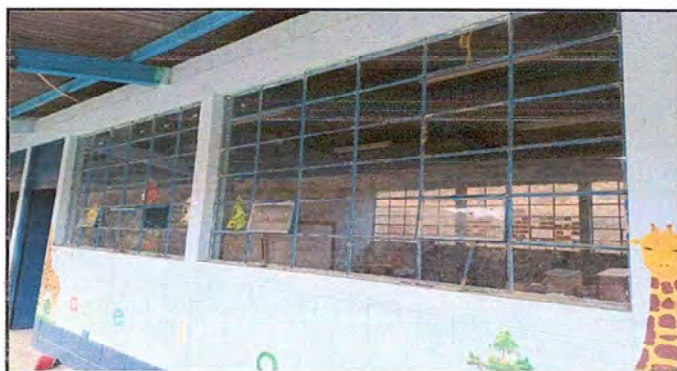
Foto 4: Módulo 1: Pintura general de paredes exterior e interior.
