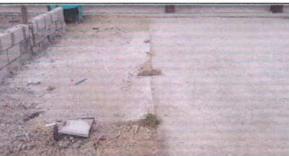
FOTO No. 17 PISO: Reparación de torta de cementos en el patio.
