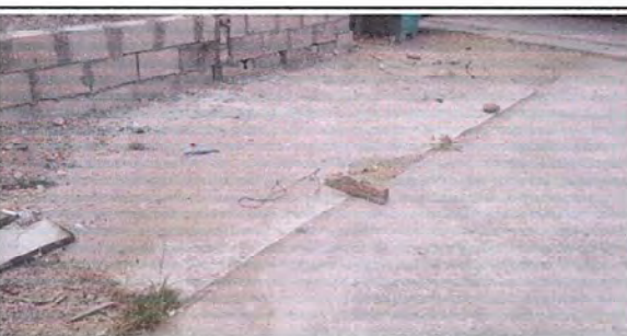
FOTO No. 18 PISO: Reparación de torta de cementos en el patio.
