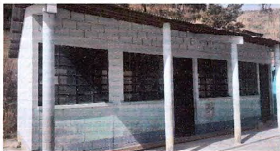
FOTO No. 13 MODULO 4: Pintura en interior y exterior de paredes.
