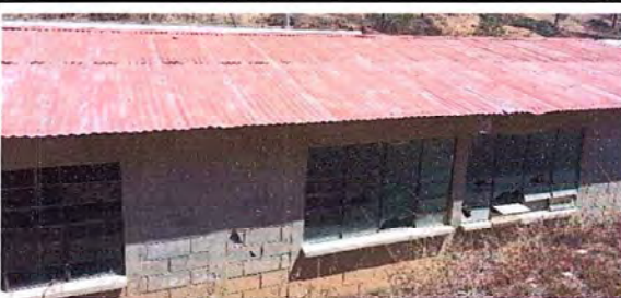
FOTO No. 15 MODULO 4: Sustitucion de lamina por lamina troquelada.
