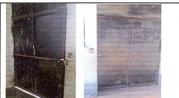
FOTO No. 11 MODULO 4: Mantenimiento de estructura de puertas.
