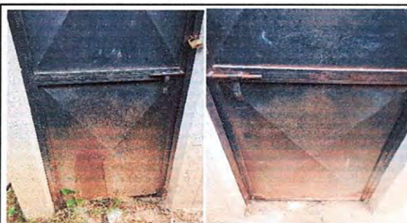
FOTO No. 10 MODULO 3: Mantenimiento de estructura purtas de sanitarios.
