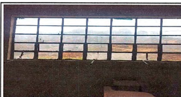
FOTO No. 6 Foto : MODULO: 2 Mantenimiento de estructura de ventanas.
