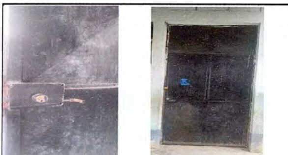
FOTO No. 3 MODULO 1: Manttenimiento de estructura de puertas.
