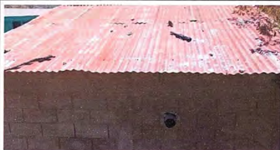
FOTO No. 1 MODULO 1: Sustrución de techo de lamina.
