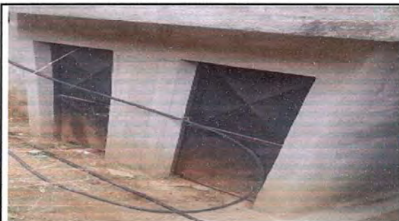
FOTO No. 9 MODULO 3: Mantenimiento de estructura puertas y pintura de sanitarios.
