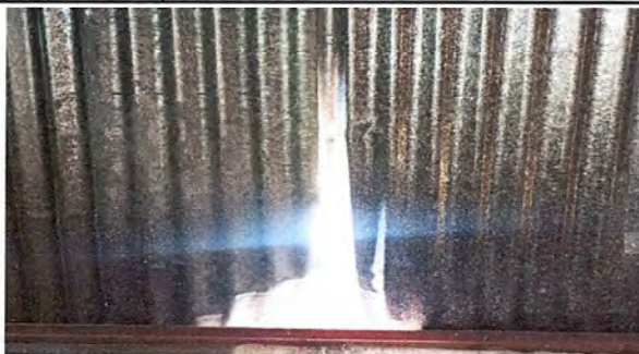
FOTO No. 2 MODULO 1: Sustrución de estructura de soporte.
