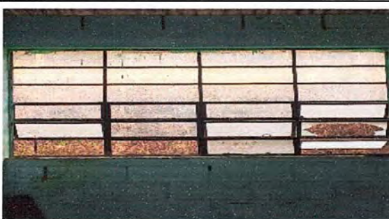
FOTO No. 16 MODULO 4: Mantenimiento de ventanas y sustitucion de vidrios.
