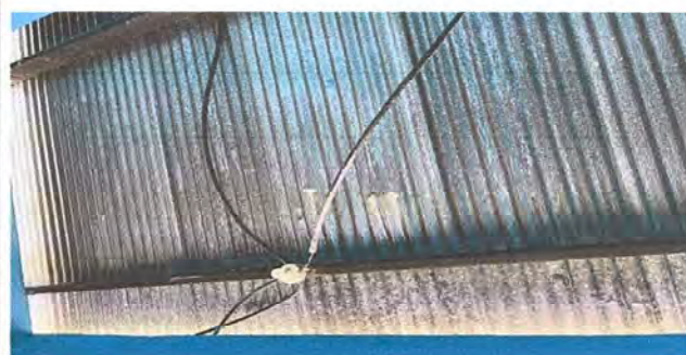
Foto 8 Módulo 1: Instalación de unidad de luz (Incluyendo interruptor, ducto y cableado)
