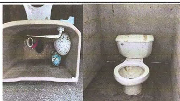
Foto 6 Módulo 1: Sustitución de inodoros
