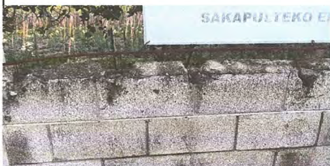
Foto 7 Módulo 1: Reparación de muro perimetral de blok
