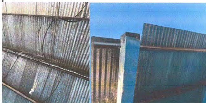
Foto 2 Módulo 1: Sustitución de estructura de soporte de metal, por metal
