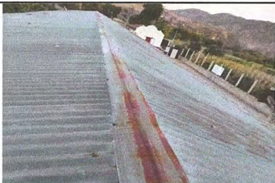
Foto 1 Módulo 1: Sustitución de lámina, por lámina troquelada calibre 26
