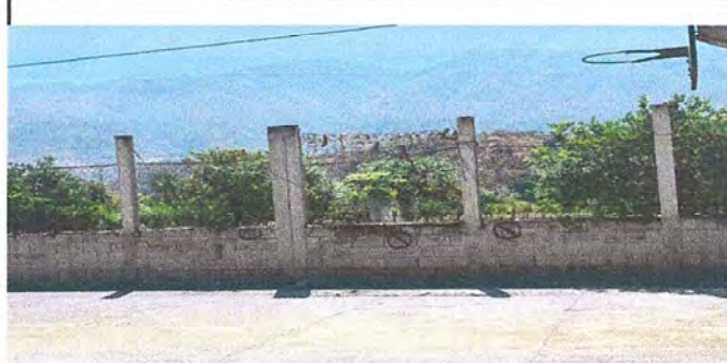
Foto 4 Módulo 1: Pintura de muros exteriores e interiores
