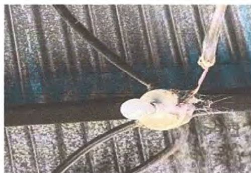
Foto 10 Módulo 1: Sustitución de Plafoneras
