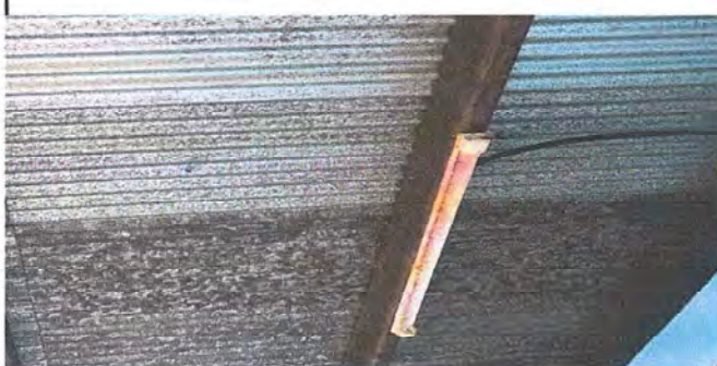
Foto 9 Módulo 1: Sustitución de lamparas led
