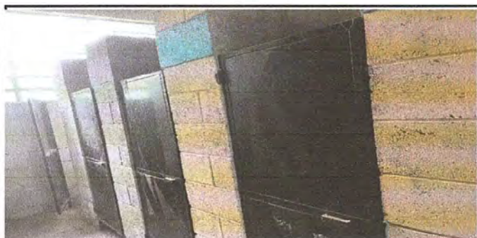
Foto 5 Módulo 1: Mantenimiento de estructura de puerta (lijado, cambio de tubo, cepillado, sujeciones, aplicación de pintura) a puertas de servicios sanitarios
