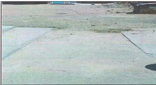
Foto 9: Patio reparación de planchas de concreto
