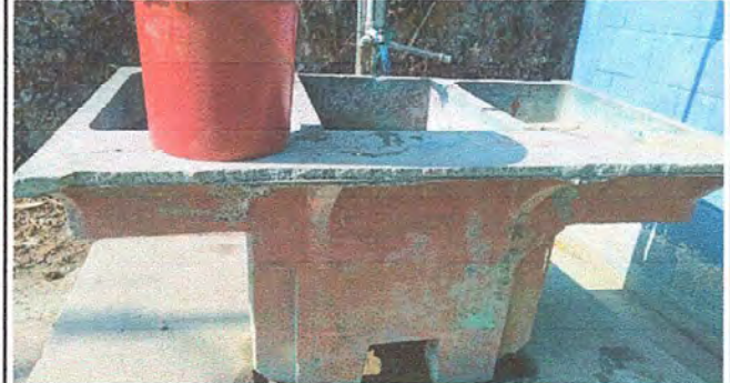
Foto 8: MODULO 2: Sustitución de pila de cemento de dos lavaderos
