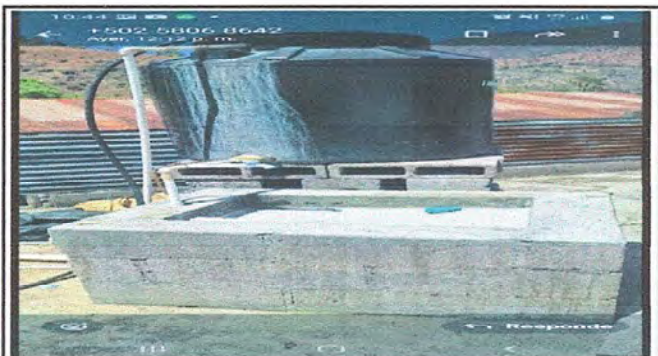
Foto 10: MODULO 3: Sustitución de deposito de agua de 1,100 litros
