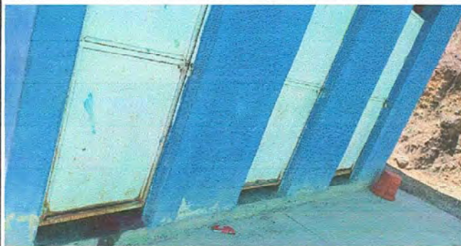
Foto 7: MODULO 2: Mantenimiento a estructura de puerta
